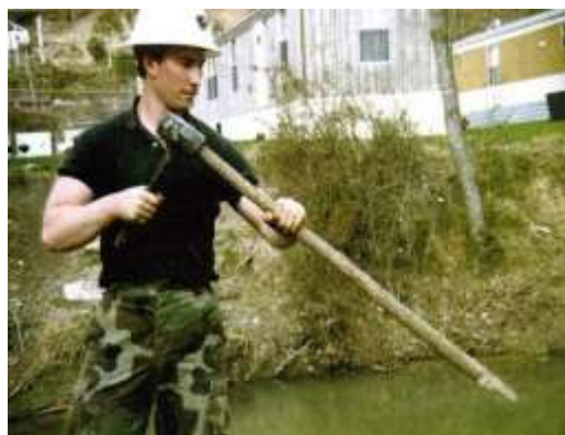
Operario con estaca viva preparada para su instalación (SCS, 1992)
