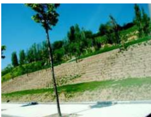
Terraplén estabilizado con geotextil con césped, arbustos y árboles.
