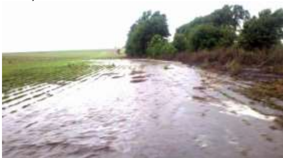
Figura 5.11.b: Canal de terrazas de desagüe funcionando (A. Montesano, INTA)
