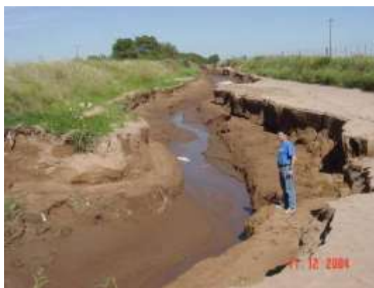
Cárcava en camino rural cuenca Arroyo Chico (Córdoba).
