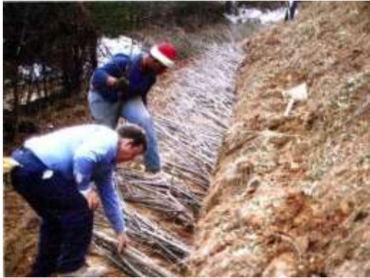
Colocación de colchón de ramas (SCS, 1992)
