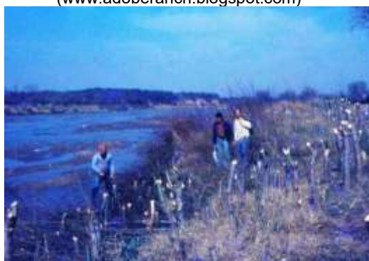
Estacas vivas atadas a la base de los árboles (sauces) para la protección de taludes de las riberas del río Cuarto (SECYOT-UNRC).
