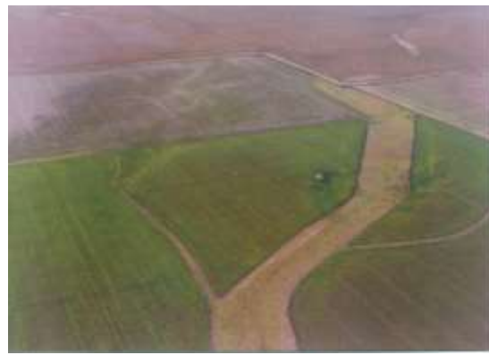
Canales de desagüe principal y canal secundario (Dpto. Río Cuarto, Córdoba) (UNRC-SECYOT).
