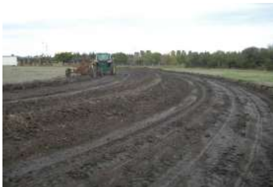
Construcción con motoniveladora de arrastre (J. Gvozdenovich, INTA Entre Ríos)
