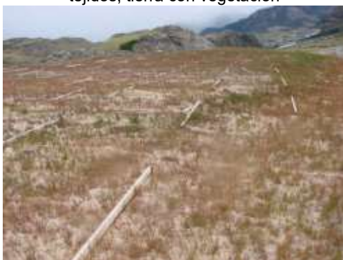
Estabilización de taludes con geotextiles que llevan incluidos tierra y semillas de vegetación herbácea, (El Chaltén, Santa Cruz, SECYOT-UNRC)
