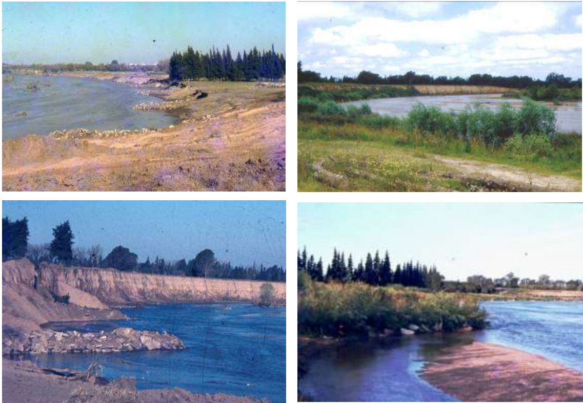
Figura 7.26: Replanteado en el terreno el proyecto de protección de la ribera se comienza la construcción de espigones aguas arriba, al inicio de la curva a proteger. La imagen derecha muestra la protección dada por la vegetación y la estabilidad creciente del sistema de espigones (SECYOT-UNRC)
