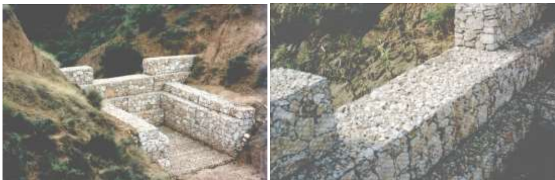
Figura 7.11: Rastrillos de retención de gavión en una cárcava de torrente (UNRC-SECYOT).
