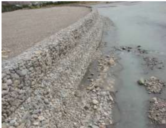
Gaviones y Espigones en el río Chaltén (UNRC-SECYOT)
