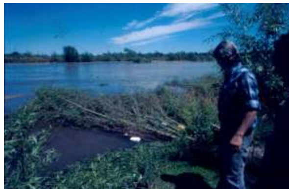
Capas de ramas y estacas vivas sobre márgenes el río Cuarto (UNRC-SECYOT)
