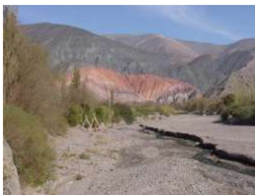
Forestación de márgenes arroyo Purmamarca, Jujuy, estabilización de las márgenes ante descargas torrenciales.
