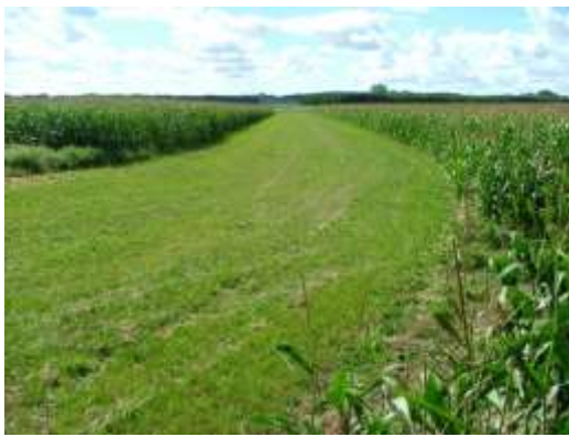
Canal de desagüe de sistematización (Ontario, Canadá)
