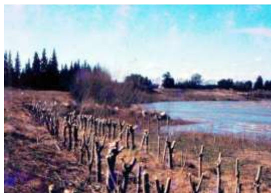
Estacas vivas brotando en un meandro del río Cuarto (SECYOT-UNRC)
