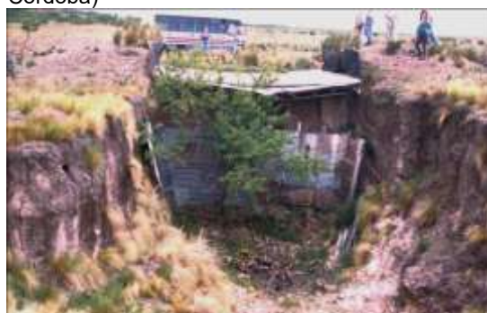
Vista general de alero con protección de chapa.
