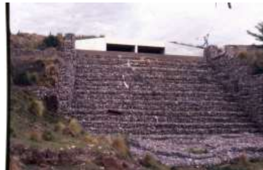
Estructura fija con escalera de gabión (UNRC-SECYOT).
