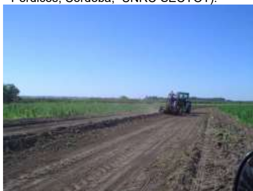
Construcción de terraza de base ancha (J. Gvozdenovich, INTA Entre Ríos)
