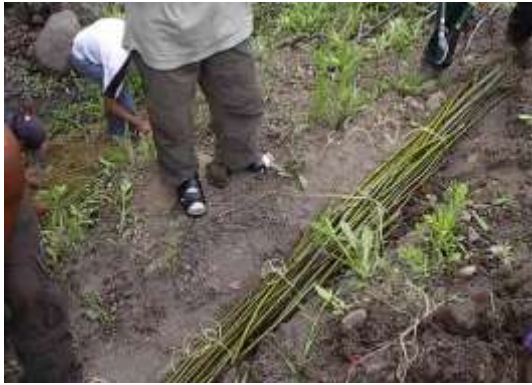
Colocación de atado de ramas vivas ( www.riparianhabitatrestoration.ca )
