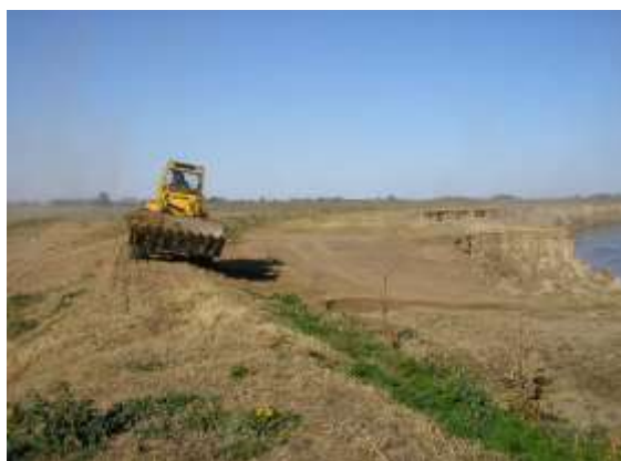
Figura 6.14: Albardones de protección y canales derivadores para protección de estructuras de defensa de cabecera (UNRC-SECYOT).
