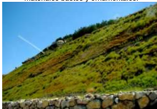
Terraplén ya estabilizado
