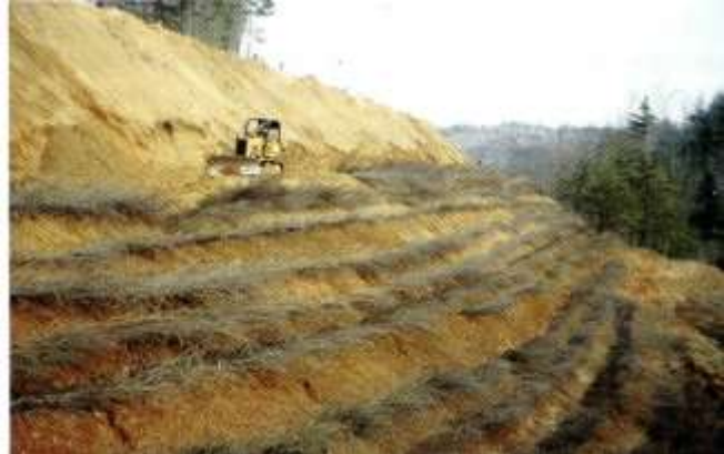
Colocación de colchón de ramas (SCS, 1992)
