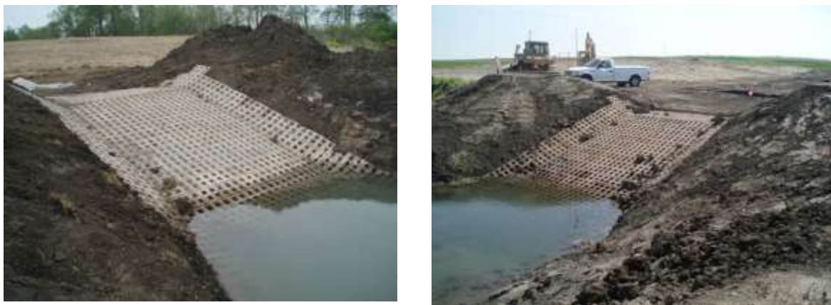
Figura 6.12: Tobogán o saetín de defensa de cabecera de de cárcavas hecho con bloques. (www.prairiestateoutdoors.com).
