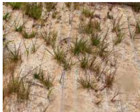
Estabilización de taludes con geotextiles que llevan incluidos tierra y semillas de vegetación herbácea, (El Chaltén, Santa Cruz, SECYOT-UNRC)
