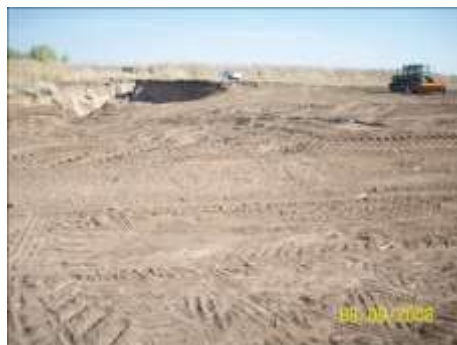
Etapa inicial del parabolizado de cárcava.
