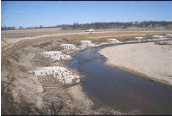
Margen de río con espigones de piedra suelta, colchón de ramas vivas y estacas
