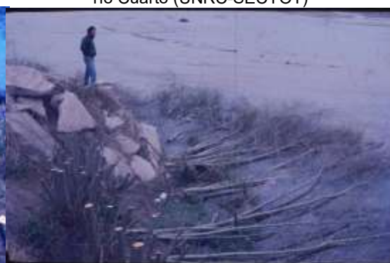
Estacas vivas atadas a la base de los árboles (sauces) para la protección de taludes de las riberas del río Cuarto (SECYOT-UNRC).
