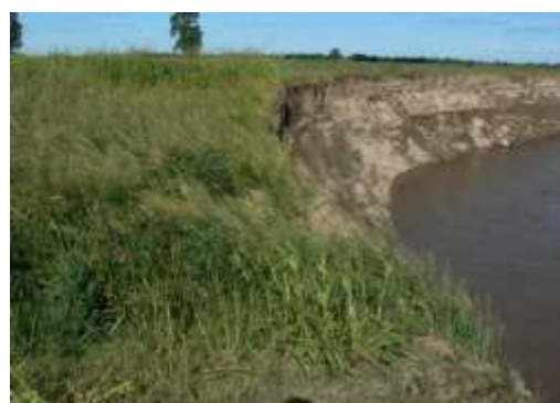
Río Cuarto, erosión de márgenes (UNRC-SECYOT)
