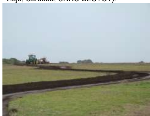
Construcción de terraza de base angosta (J. Gvozdenovich, INTA Entre Ríos)
