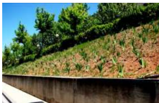
Terraplén estabilizado con arbustos, árboles, materiales bastos y ornamentales.
