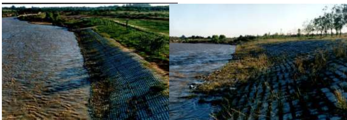
Figura 7.27: Revestimiento de orilla mediante pantallas con bloques de hormigón, costa del río Cuarto (UNRC-SECYOT).
