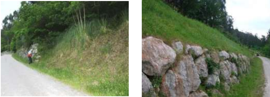
Figura 7.22.: Estabilización de laderas con base de piedras, forestación y vegetación herbácea. (Guriezo, España, SECYOT-UNRC)
