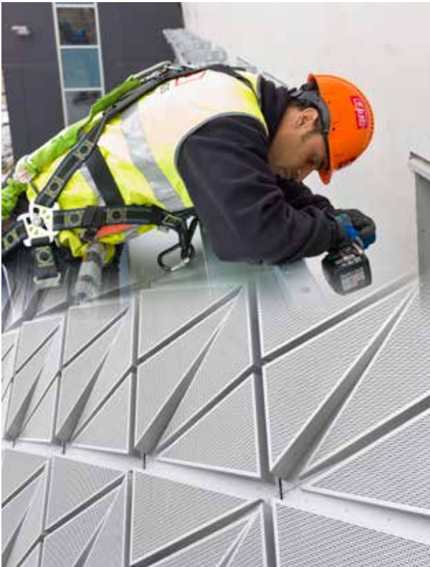
Fasadbeklädnaden på Friends Arena i Stockholm är infäst med 300 000 Marutex-skrudar, något som ger inbyggd trygghet för framtiden.
