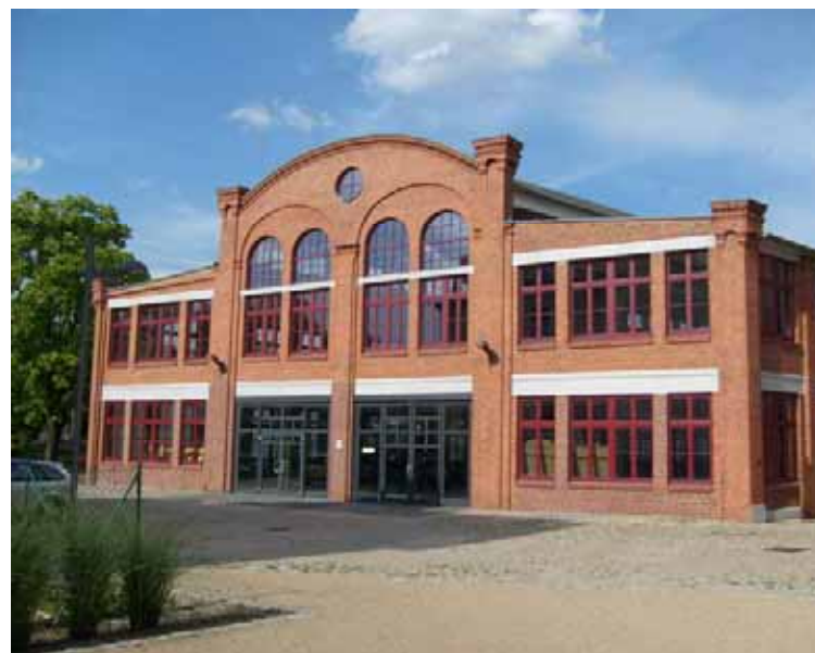
Bogenbinderhalle in Ronneburg
