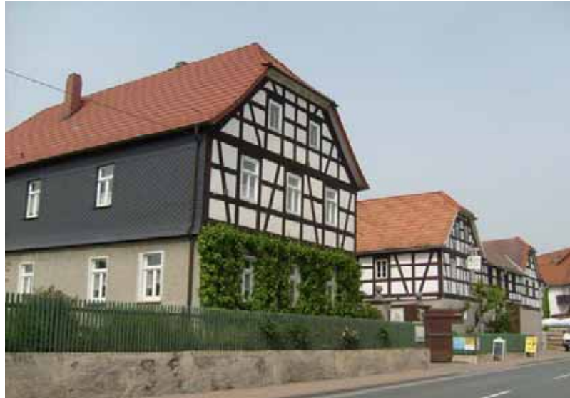
Fachwerkgebäude in Großebersdorf
