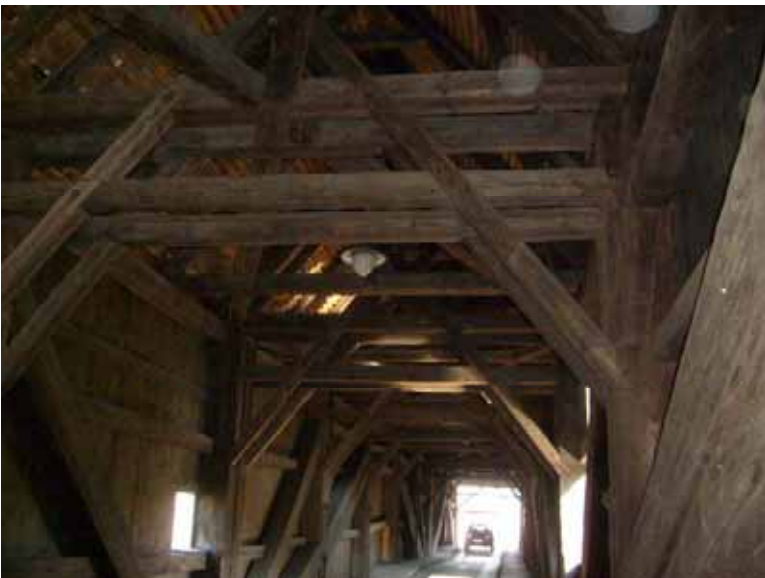
überdachte Holzbrücke von Wünschendorf
