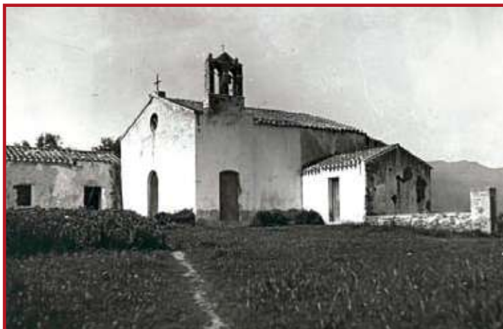
La chiesa prima del restauro, sulla sinistra la casa del custode, sulla destra la sacrestia e parte del muretto che circondava la piazza
