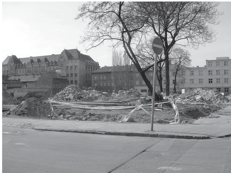
6. kép Egykor a Lenhossék park helyén álló épület bontás után
