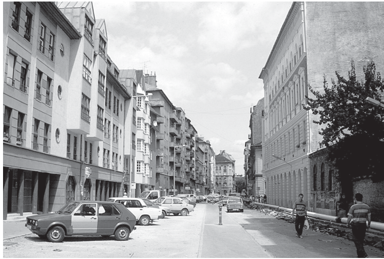
1. kép A Tompa utca felújítás előtt
