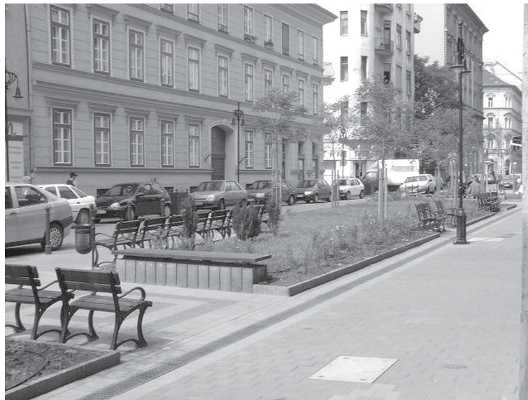
2. kép A Tompa utca felújítás után
