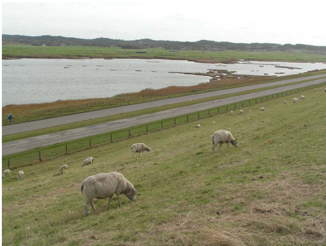
Figuur 18. Grasmat binnentalud Hondsbossche Zeewering ter hoogte van De Putten; schapenbegrazing na maaien en afvoeren (foto C.J. Smit).
