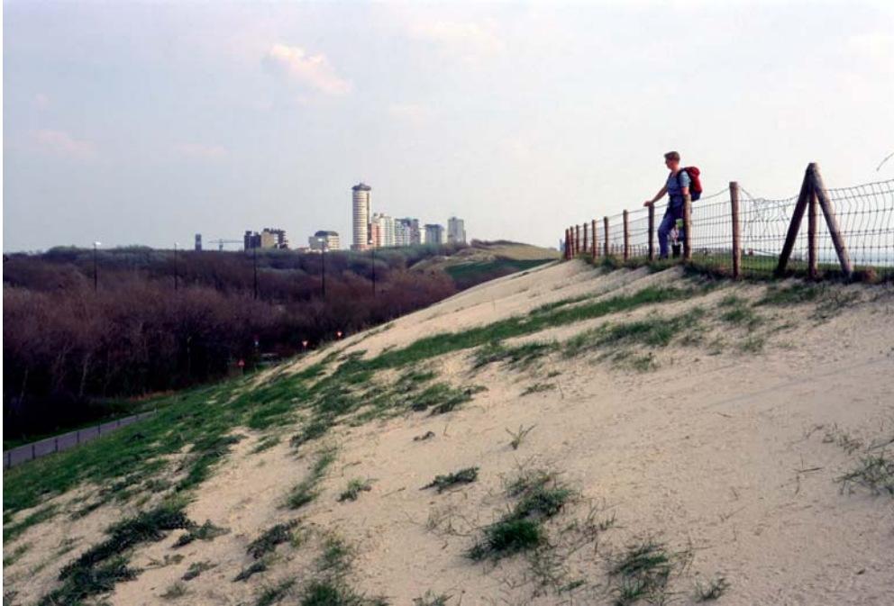
Figuur 20. Zand stuift over de dijk heen en sedimenteert op het binnentalud (zwakke schakel Nolledijk bij Vlissingen).
