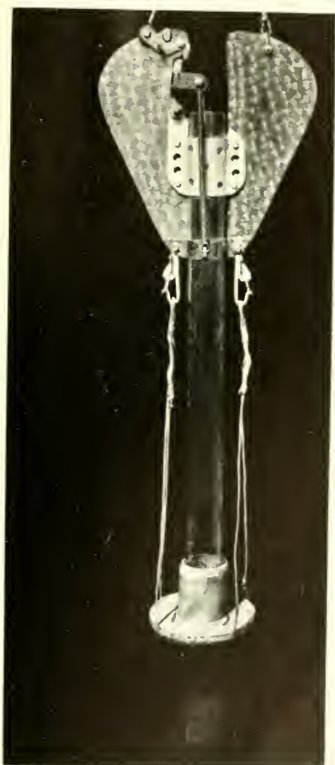
Fig. 1. Carottier à la descente, clapet ouvert.
