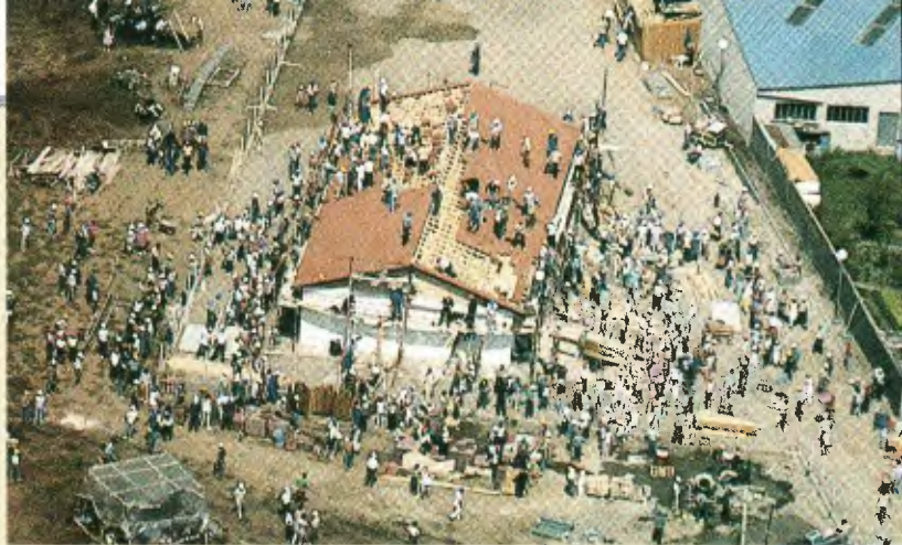
Construction rapide d’une Salle du Royaume en France, à Aurillac.
