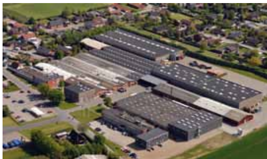
Luftbildaufnahme der Produktionshallen TRIAX A/S
