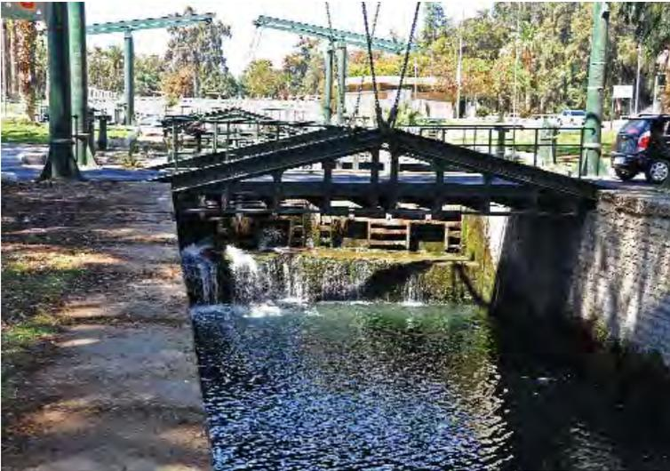
**Links:** der Ismailia-Kanal liegt an seiner Mündung in den Timsahsee etwas höher als der See. Schleusen verhindern, dass salzhaltiges Wasser in den Kanal zurück strömt, dessen Wasser für die Bewässerung von agrarisch genutzten Feldern verwendet wird.
