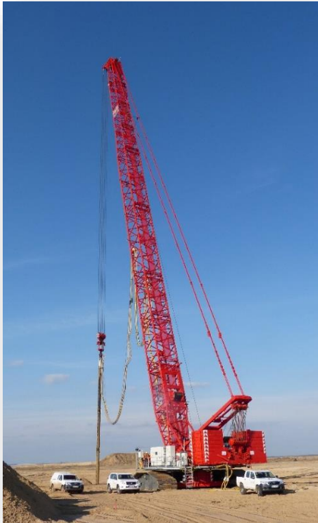
TGB Jänschwalde, Depot 3. BA LR 1750 Rüttelteufe bis 65 m
