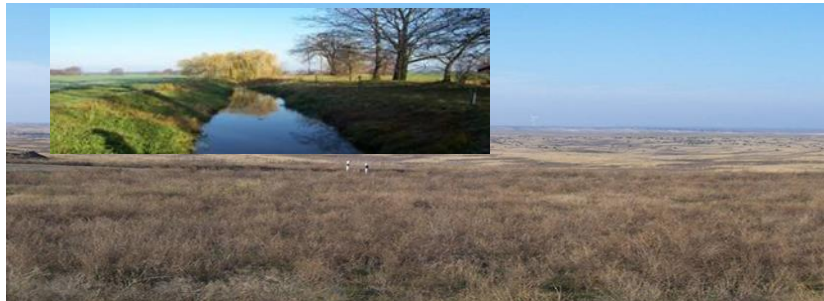
Rückverlegung Malxe (Quelle: LEAG)
