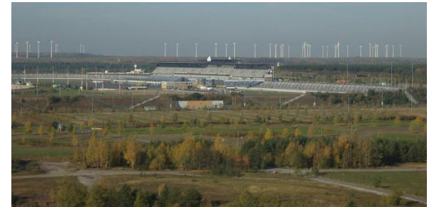
Windpark Klettwitz (Quelle: LMBV)
