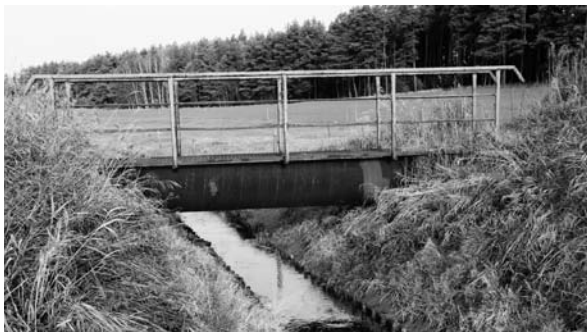
Rurociąg nawadniający nad Parzenicą w okolicach Brody.
