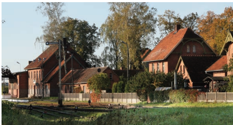
Fot. 23. Kompleks zabytkowych budynków dworca kolejowego w Brusach
