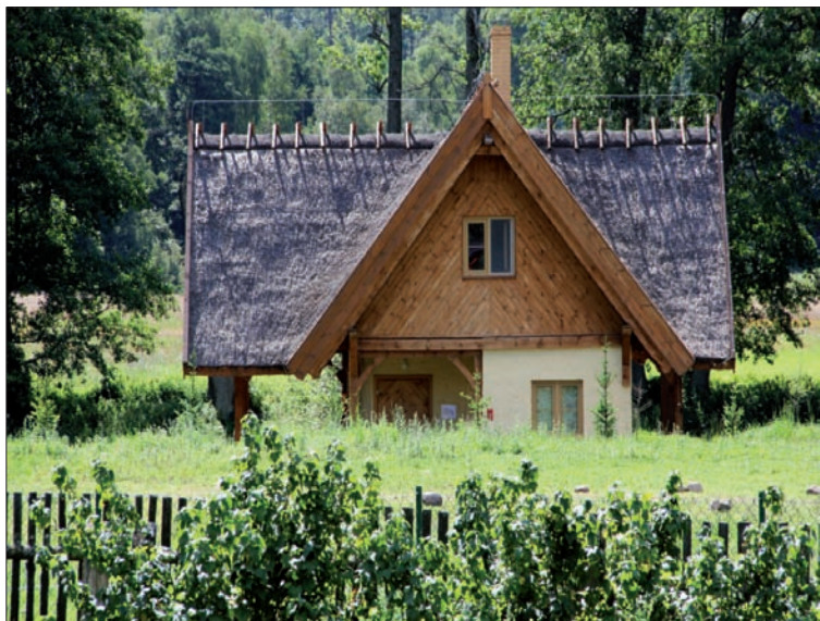
Fot. 82. Stanica wodna w Lasce
