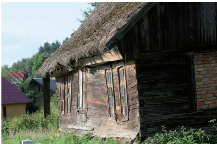
Fot. 46. Chata w Wysokiej Zaborskiej
