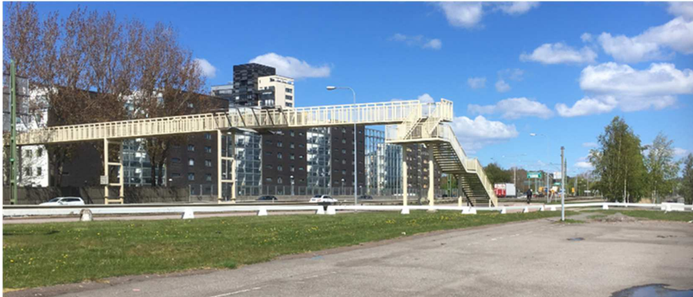
Figur 8. Otillgänglig gångbro i Frihamnen över Hamnbanan och Lundbyleden.
