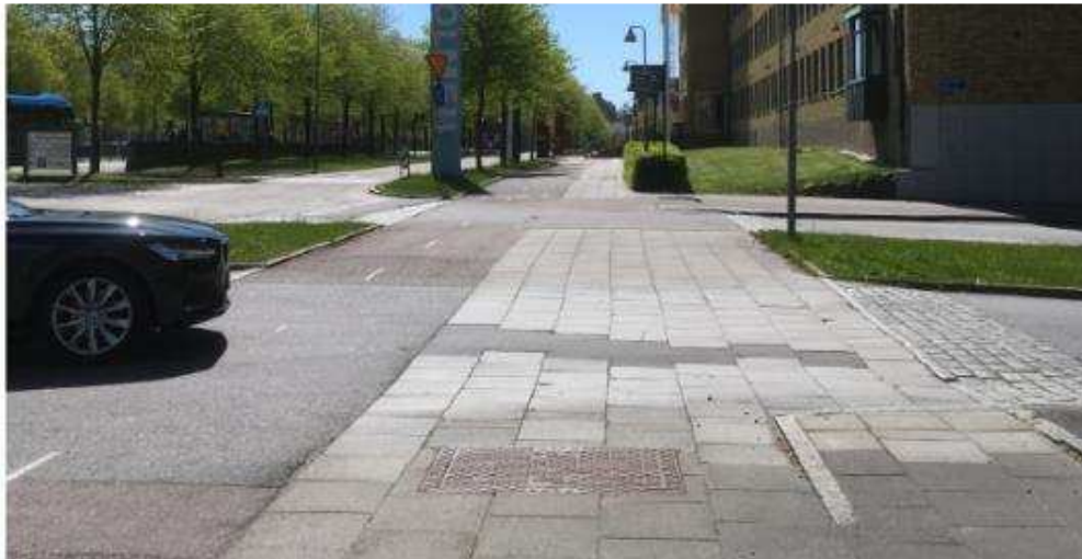
Figur 16. Förhöjd passage med smågatsten mot Lindholmsallén, gångbanepaltor som fortsätter över anslutande körbana samt kantstöd för synsvaga.
