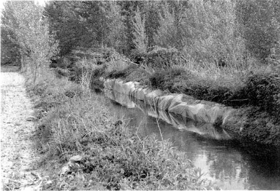
Detalle de la acequia de los Galachos con plásticos protectores para evitar filtraciones.
