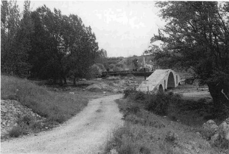
La acequia Molinar atravesando con un sifón el cauce del río Pancrudo.
