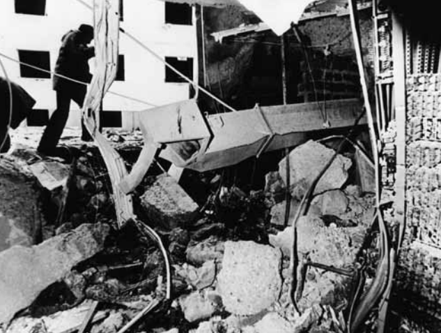
RFE/RL galvenā mītne Minhenē pēc ēkas viena spārna uzspridzināšanas (1981.II)
