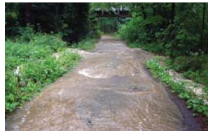
Fot. 3. Podczas nawalnego opadu w sierpniu 2006 r. wszystkie drogi i rowy przydrożne pełniły funkcję kolektorów prowadzących wodę. Widok na drogę leśną przy wiadukcie kolejowym – linia Jelenia Góra – Szklarska Poręba, odcinek środkowy doliny Małej Kamiennej (fot. M. Kasprzak).
