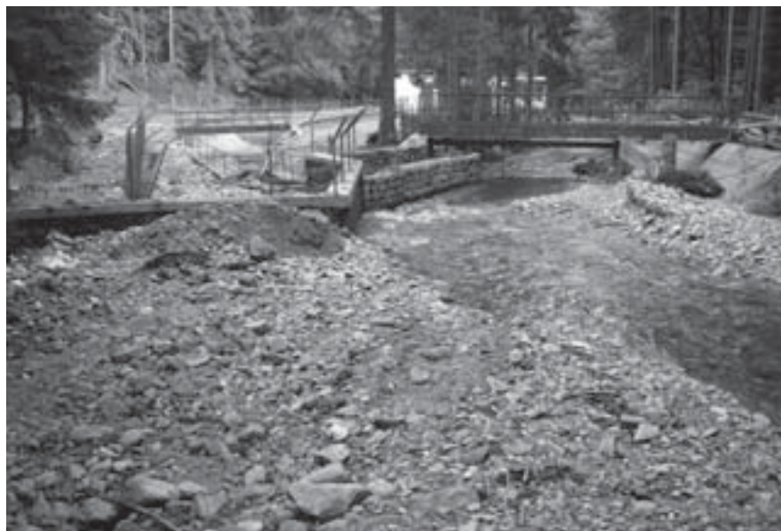
Fot. 10. Dno doliny Małej Kamiennej zasypane grubofrakcyjnym rumowiskiem w miejscu blokowania odpływu przez przeszkodę w postaci ujęcia wody. Akumulacji sprzyjało zarówno spiętrzenie nurtu, jak i lokalne rozszerzenie dna doliny oraz zmniejszenie spadku podłużnego cieku (fot. M. Kasprzak).
