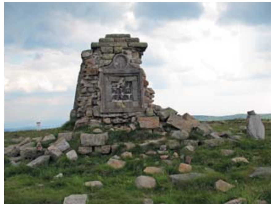
Fot. 3. Ruiny pomnika Wilhelma I na Wielkim Szyszaku. Ze względu na użycie zaprawy murarskiej obiekt jest nieprzydatny do datowania lichenometrycznego (fot. S. Kędzia).
