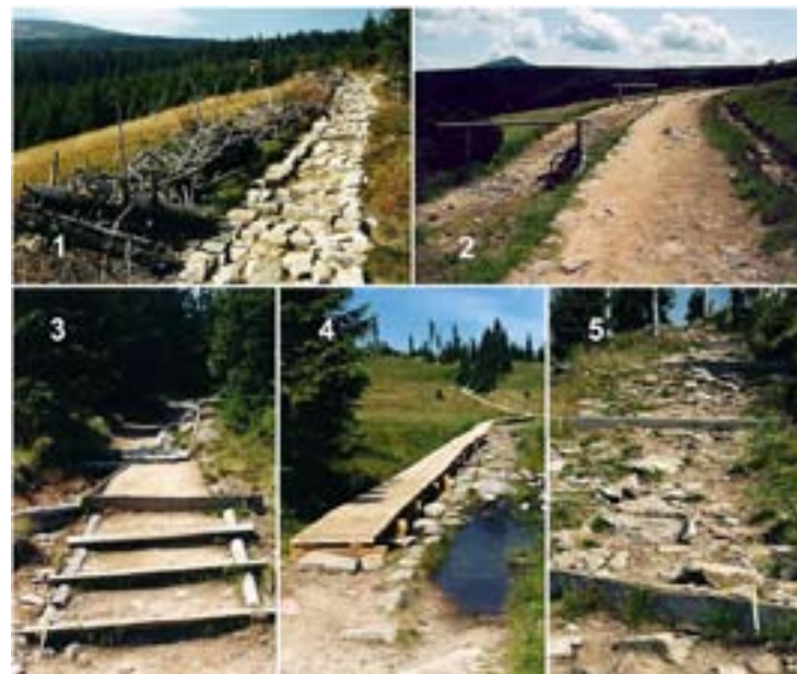
Fot. 5. Sposoby zabezpieczenia powierzchni szlaków turystycznych stosowane w Karkonoszach: przeszkody zniechęcające turystów do wydeptywania poboczy dróg (1 i 2), stopnie niwelujące lokalne przewyższenia (3), kładka ułatwiająca pokonanie podmokłego odcinka (4), progi ograniczające splukiwanie materiału skalnego (5) (fot. M. Kasprzak).
