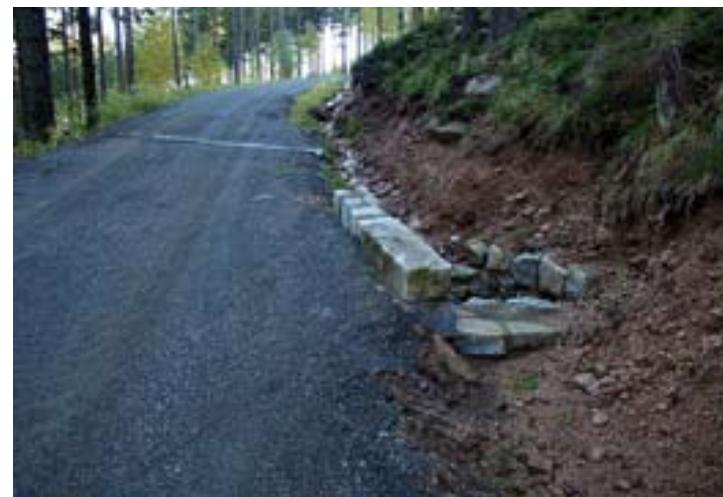
Fot. 6. Wkop drogowy na odcinku drogi leśnej podcina pokrywę stokową i przechwytuje spływ śródpokrywowy. Wodę odprowadza rów przydrożny a niezabezpieczona ściana wkopu ulega podmywaniu (fot. M. Kasprzak).
