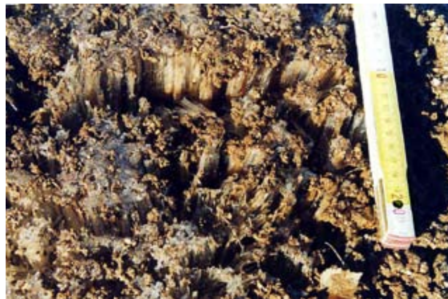
Fot. 1. Uniesienie przez lód włóknisty materiału skalnego z powierzchni drogi górskiej ułatwia jego przemieszczenie w wyniku splukiwania lub mechanicznego zrywania (fot. M. Kasprzak).
