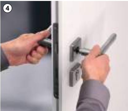
4 Kolları takın ve inbus civatayı sıkın
