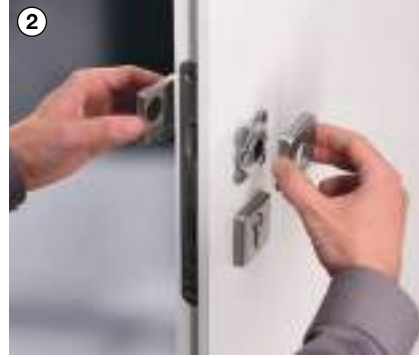
2 Rozetleri konstrüksiyon üzerine klipsleyin
