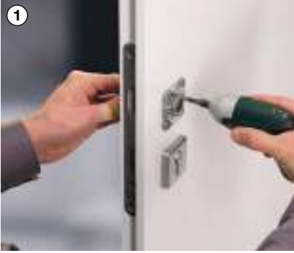
1 Alt konstrüksiyonu takın ve sıkıca vidalayın
