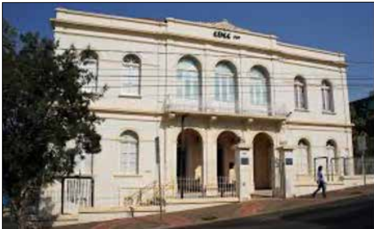
Figura 8: Sede original del Instituto de Física e Química de São Carlos.
