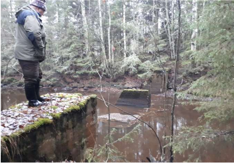
Bild 9. Det gamla dammläget med rester från dammen från 1930-talet.
