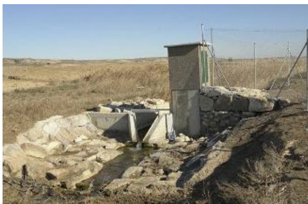
Ilustración 57. Estación de aforo y muestreo de Landazuría (vertedera de tipo H del SCS). (Fuente: Gobierno de Navarra, Negociado de Suelos y Climatología).
