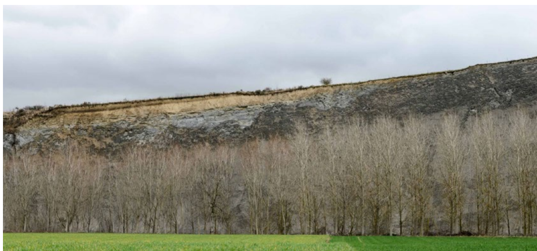
Ilustración 40. Perfil en Eriete. Se observa claramente la erosión de la parte alta de la ladera a la derecha de la imagen y la acumulación de parte de ese material sobre el perfil de la parte baja a la izquierda de la imagen. (Fuente: Jokin del Valle de Lersundi).
