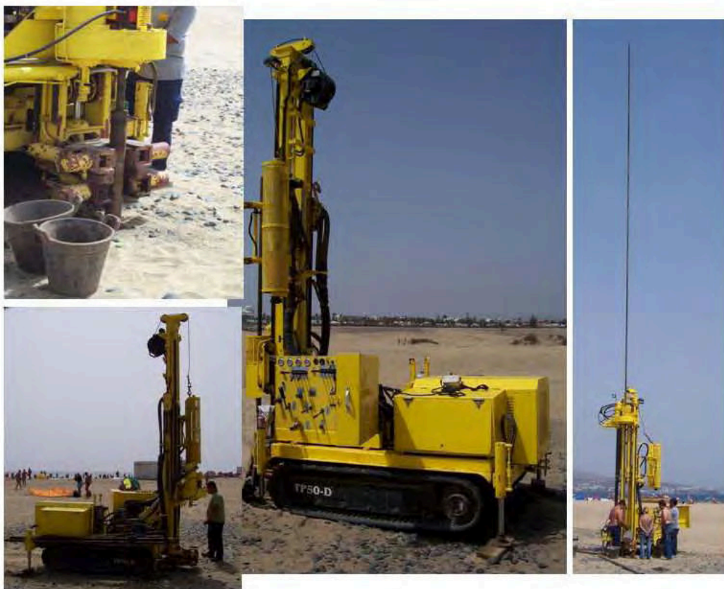
Figura 6.2. Imágenes de la máquina TP-50D con la que se realizó el sondeo en el lugar de perforación.
