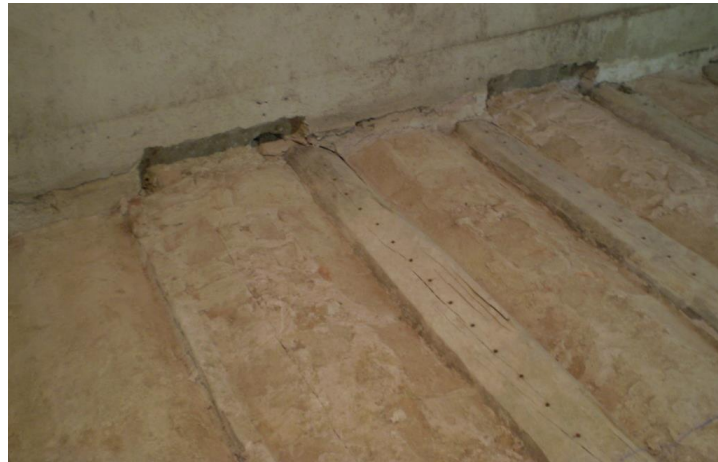
Grietas (fendas) en encaje vigueta madera
