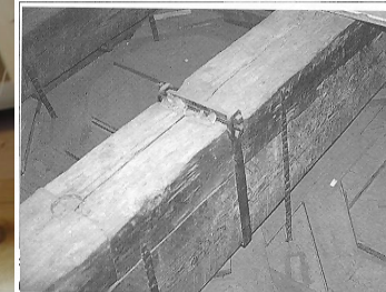
Foto 4. Les abrazaadores de ferro forjat, han estat molt utilitzades en la lligada de clivelles i també en la unió de diverses peces per fer-les treballar de manera unitària.
