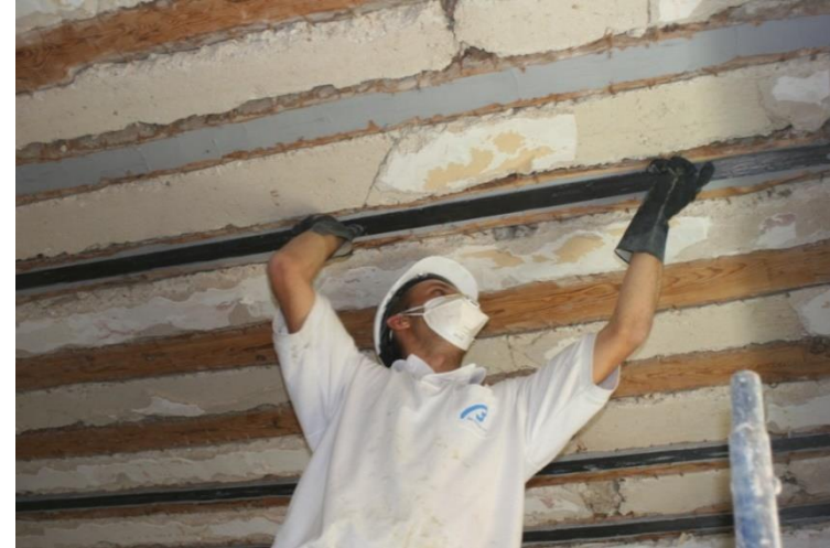
Refuerzo mediante laminados de fibra de carbono: lateral o inferior (Kimitech – Kimia)
