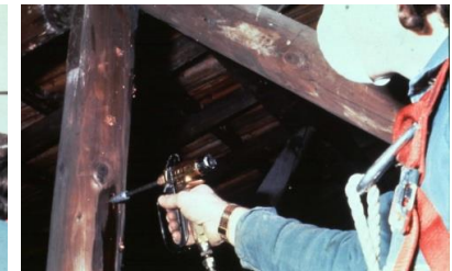
Colocación de válvulas de retención e inyección posterior de líquido.
