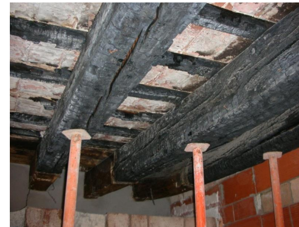
Daños estructurales por fuego en un forjado de una planta cuarta
