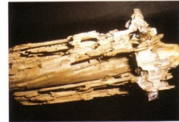
Foto 10. Danys produïts per tèrmits subterranis en una bigueta de sostre.
