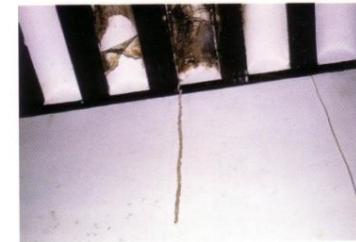
Foto 11. Camins o xemeneies construïts pels tèrmits subterranis per accedir a la fusta.
