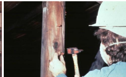
Colocación de válvulas de retención e inyección posterior de líquido.
