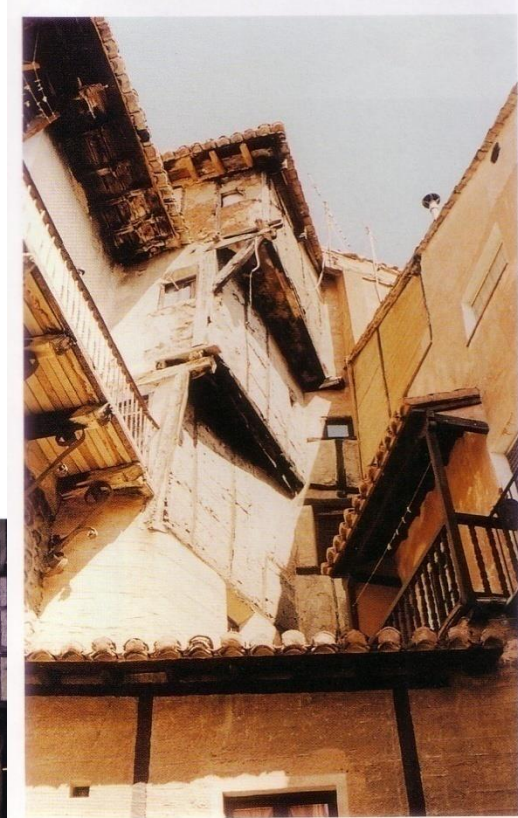
8. Este ejemplo de Albarracín nos muestra la gran facilidad que ofrece la madera a la construcción de vuelos allí donde sea posible por inverosímil que parezca.
