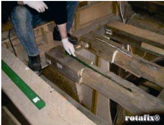
Instalación de placas de refuerzo metálicas internas con epoxi – longitud libre máxima – F.Arriaga
