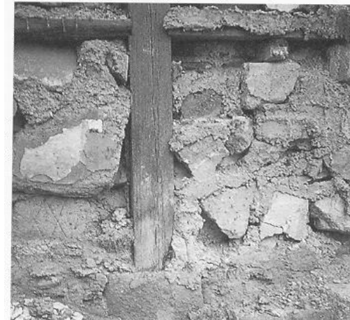
El granito, como otras piedras poco porosas, han sido la barrera más habitual para evitar que el terreno y la humedad estén en contacto directo con los elementos de madera.
