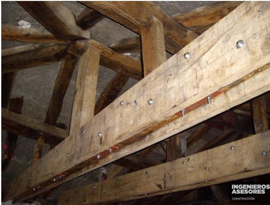
Refuerzo con piezas de madera unidas con pernos (Ingenieros Asociados)
