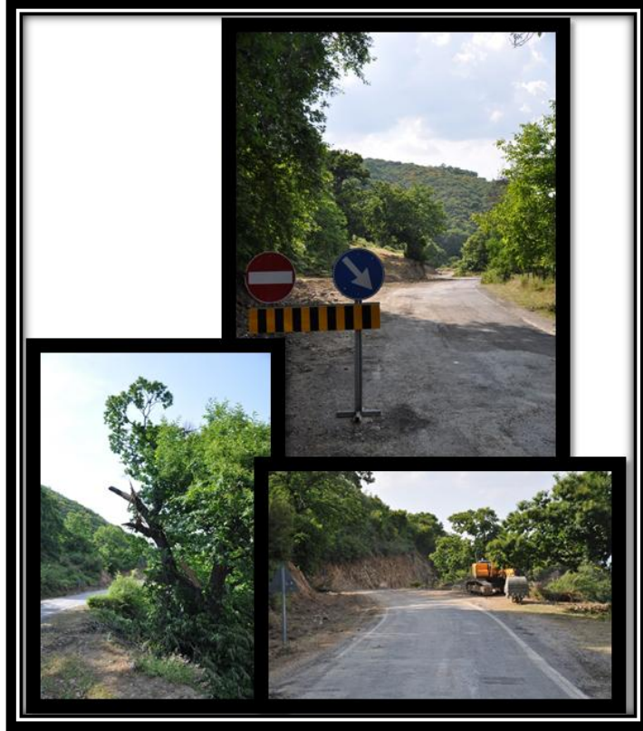
Şekil 3.17 2011 yılında TCK'nın Güme Dağı'nda yol genişletme çalışmaları.
