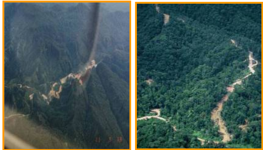
Foto 5. Pembangunan kontruksi PLTA Sipansihaporas (kiri) dan pembersihan kayu oleh PT. Teluk Nauli di Blok Anggoli (kanan) telah menyebabkan kerusakan dan fragmentasi habitat orangutan Sumatera di DAS Batang Toru
