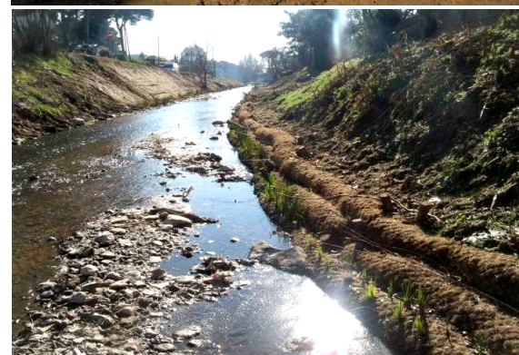
Imágenes de la fase de construcción (fase intermedia durante las obras)
