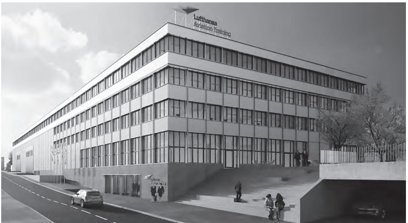
Neubau der Lufthansa Aviation Training in Glatthbrugg.
