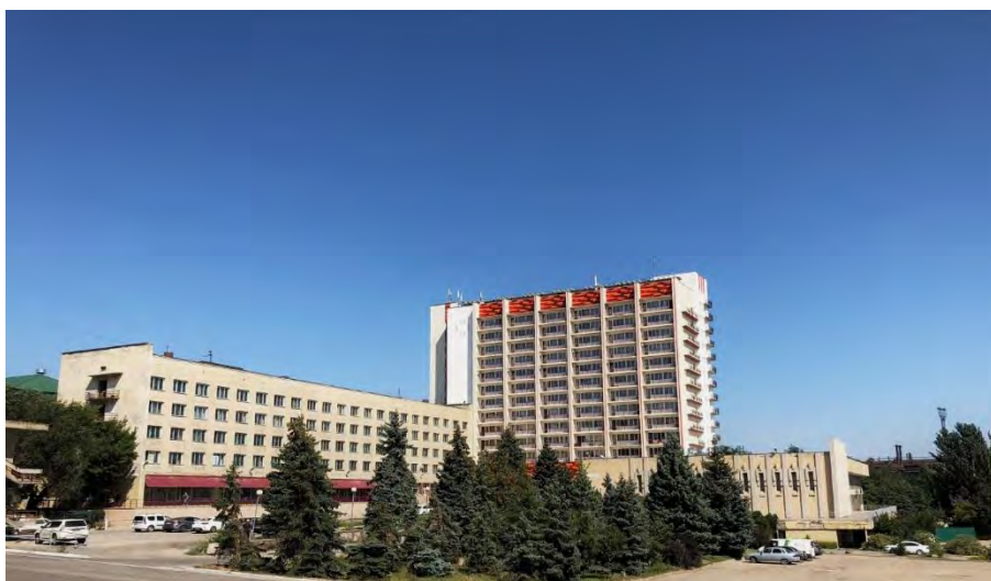
Рисунок 1 – Фасад здания, общий вид гостиницы «Турист»
