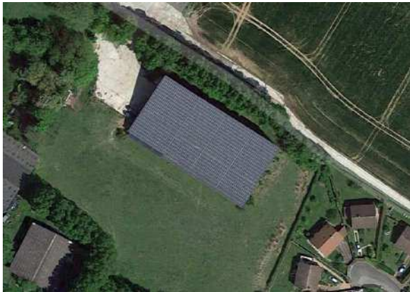
Figure 63 : Photo aérienne de la principale installation photovoltaïque de Millencourt-en-Ponthieu
