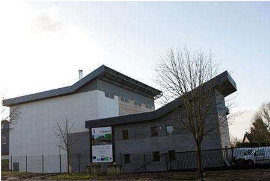
Figure 70 : Chaufferie bois-énergie du réseau de chaleur d'Abbeville.
