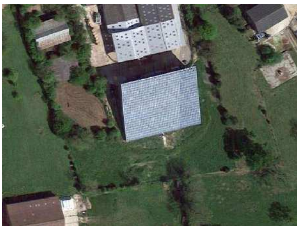
Figure 64 : Photo aérienne de la principale installation photovoltaïque de Coulouvillers
