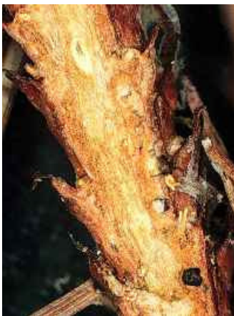
Foto nº 5: Daños en tronco
