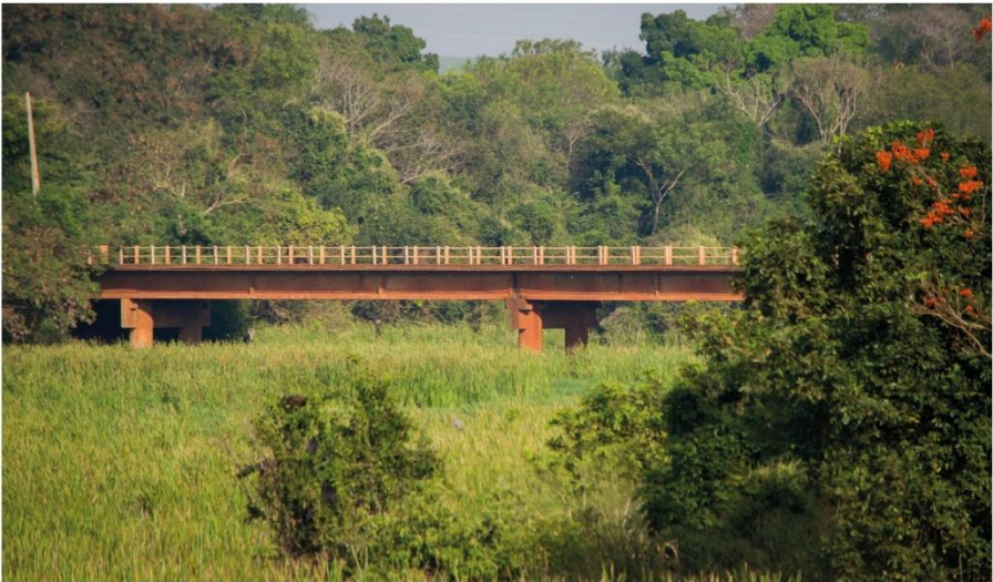
Foto 3 - Ponte sobre o Rio Jaú
