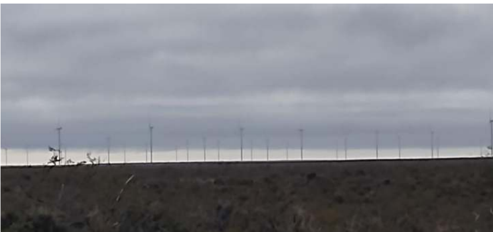
Fotografías 20, 21 y 22. Aerogeneradores Parques Eólicos de otras empresas: Vistas varias desde la La Flecha
