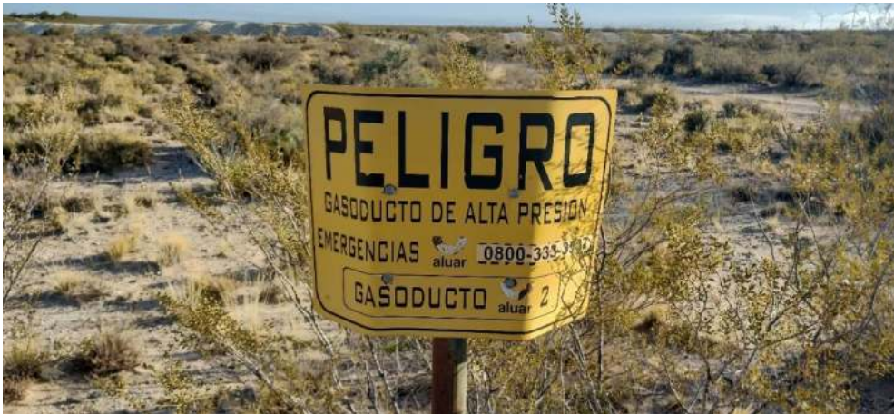
Fotografías 32 y 33. Gasoducto Aluar: La Flecha
