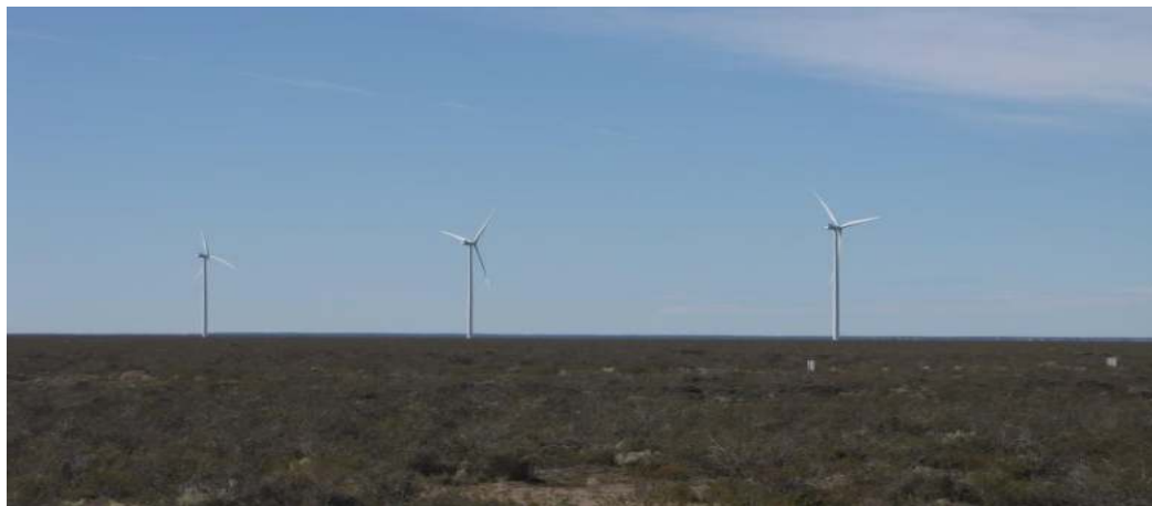
Fotografías 26. Aerogeneradores Parque Eólico Aluar Etapas I, II, III: Vista desde La Flecha
