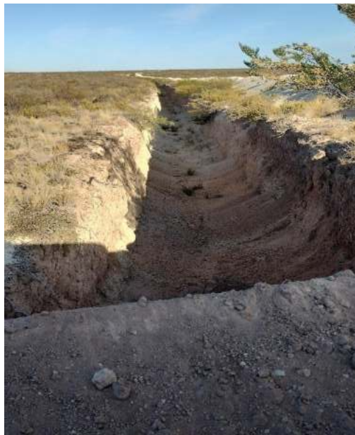
Fotografía 34. Zanja de resguarda próximo a La Flecha
