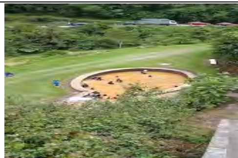
Figura 2. Fotografía del Balneario “Piscinas El Cachaco”.
