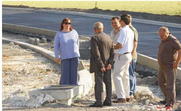
Sur le chantier du contournement de Cantin, la première « route durable » dans le Nord, la concertation avec les riverains a été importante. PH. PH.
