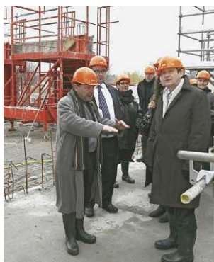
Lors de la visite de chantier le 28 février dernier. PH.EW
