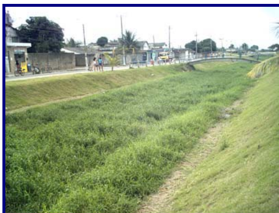
Foto 6.1.4.3: Canal da Liberdade
