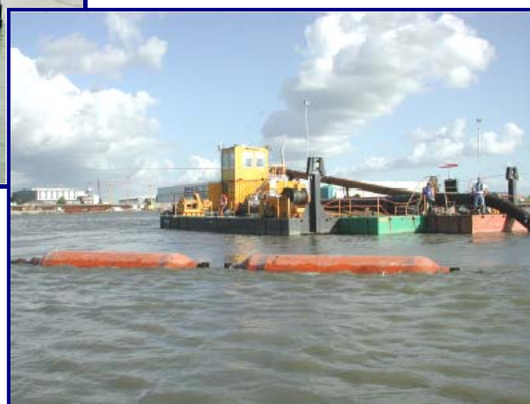
Figura 3.4.11: Esquema de chegada do tubo de recalque em plataforma flutuante descarregando por meio de difusor.
