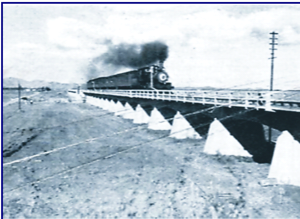
Figura 6.3.27: Na foto, A Velha Maria Fumaça que Fazia a Ligação de Santa Cruz até Mangaratiba, Passando por Itaguaí, Itacuruçá, Muriqui, Ibicui e Praia Grande. Observe-se a Construção da Via, Elevada, não sobre aterro, mas Sobre uma Ponte, e Embora Inexista Qualquer Rio no Local. Este Tipo de Construção é Típico de Áreas de Baixada Sujeita a Alagamento, Permitindo o escoamento de Águas Durante o Período de Chuvas, sem Represá-las. Um Claro Sinal dos Problemas de Drenagem de Santa Cruz.
