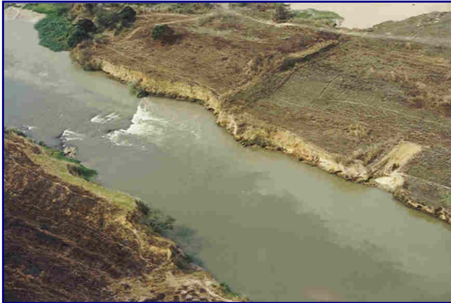
Figura 6.1.3: Erosão das margens
