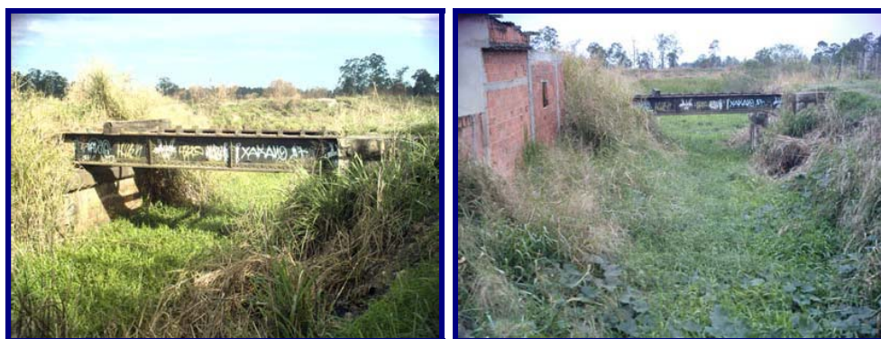
Fotos 6.1.4.6: Obra de Arte no Canal São Fernando – Ponte da R.F.S.A.
