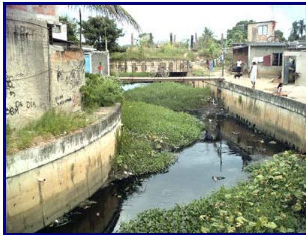
Foto 6.1.4.7: Obra de Arte no Canal da Liberdade – Ponte da Av. João XXIII
