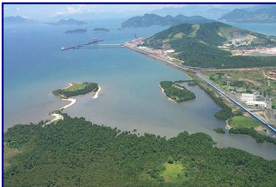
Figura 3.2.3: Vista do Porto de Sepetiba, onde se localiza o terminal da CPBS, distante cerca de 4 km da área.
