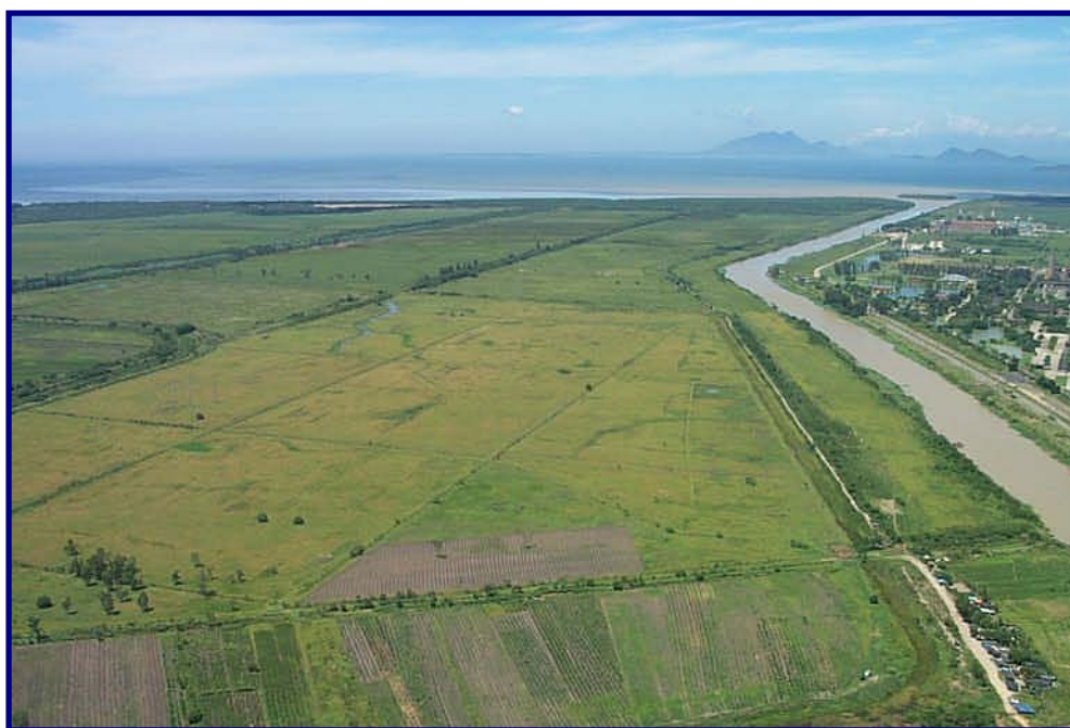
Figura 6.3.13: Panorama entorno do terreno Usina Termoeletrica de Santa Cruz e a Cosigua, pela margem, terreno da CNEN, ao que se segue a Base Aérea de Santa Cruz, pela margem esquerda e, em sua parte superior, após a Av. João XXIII, dois conjuntos habitacionais: Novo Mundo e Mécimo da Silva.
