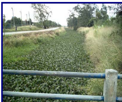
Foto 6.1.4.2: Canal de São Fernando – Vista da Ponte da Av. João XXIII
