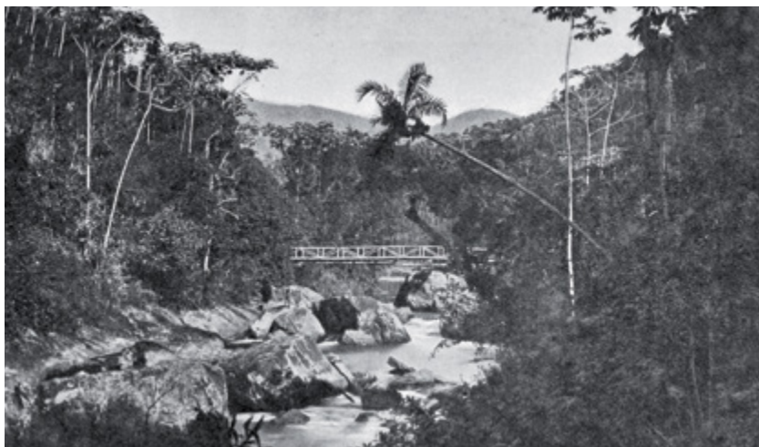
Figura 8. Ponte na Província do Espírito Santo.
