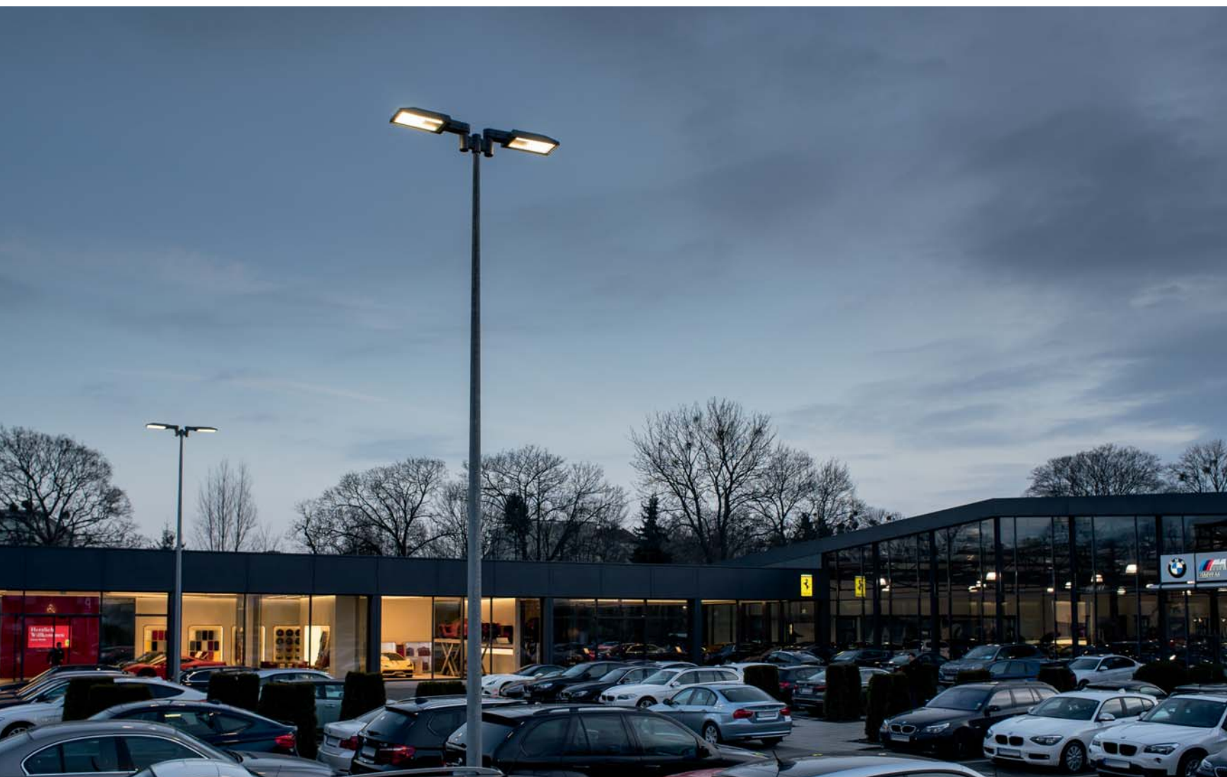
BMW Niederlassung Riller & Schnack am Hindenburgdamm, Berlin (D). Planung: Uwe Nüßer, Gebäudemanagement Riller & Schnack.
