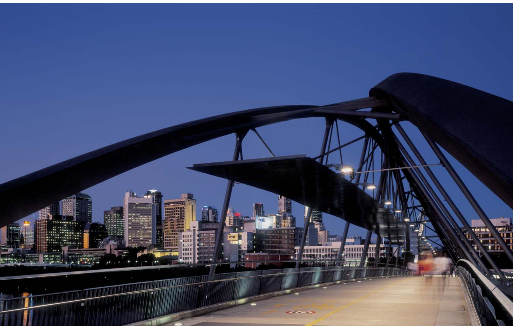
Goodwill Bridge. Brisbane (AUS). Architekt: Cox Rayner Architects. Lichtdesign: Webbs Australia.
