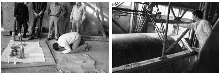
Corea del Sud, fine anni sessanta: Lamberto Venturini prepara... scientificamente la collocazione in sede dello statore dell'alternatore della centrale termoelettrica di Yosu.
