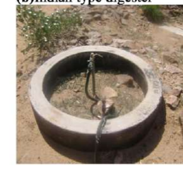
(d) abandoned digester
