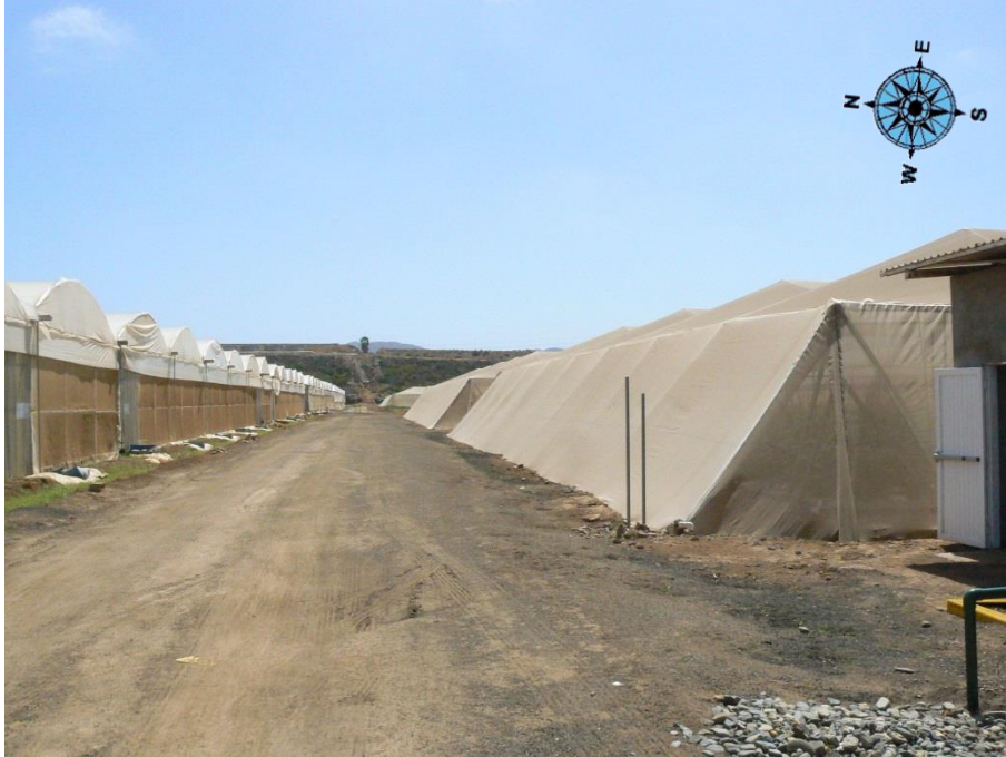
Foto 5. Camino en el interior del predio por donde sube la tubería de agua de pozo a los reservorios y baja a la planta desaladora. Este camino divide las áreas de cultivo en invernadero al Norte y en malla sombra al Sur.
