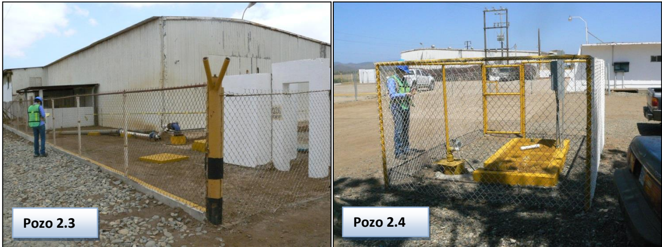
Foto 13. Vista de las instalaciones de los pozos # 2.3 y 2.4 que suministrarán agua salobre a la planta desaladora.
