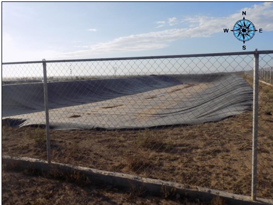
Foto 2. Reservorio de agua de pozo con capacidad de almacenar 16,000 m 3 .
