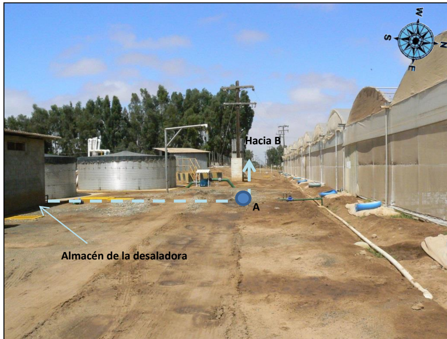
Foto 15. Vista hacia el oeste de una parte de la sección que conecta a la desaladora con el punto A.
