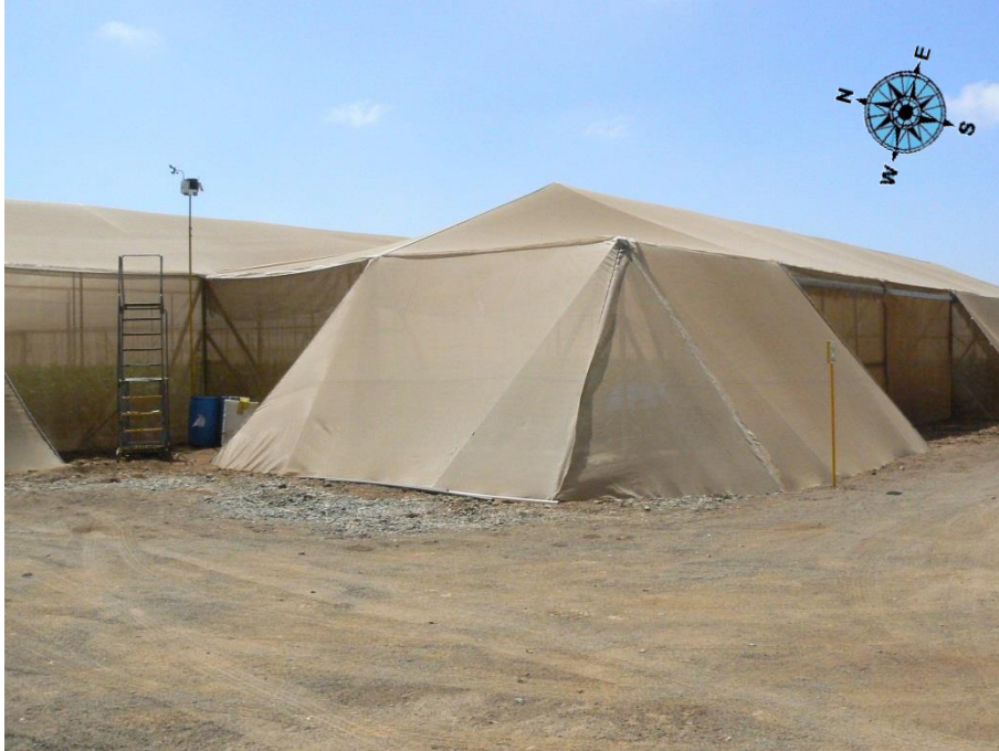
Foto 7. Cultivos en malla sombra. Estas estructuras se encuentran en un área de 658,063 m 2 .
