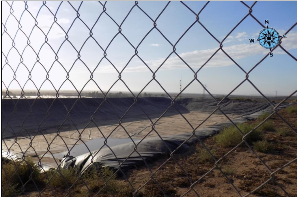
Foto 3. Reservorio de agua de pozo con capacidad para almacenar 8,000 m 3 .
