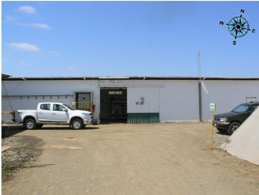
Foto 9. Vista general de la nave que guarda los módulos de osmosis inversa de la planta desaladora. El sitio está rodeado de invernaderos y cultivos en túneles.
