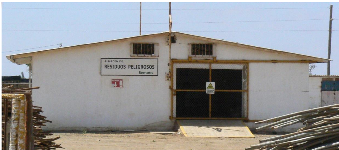
Foto 40. Almacén de residuos peligrosos.
