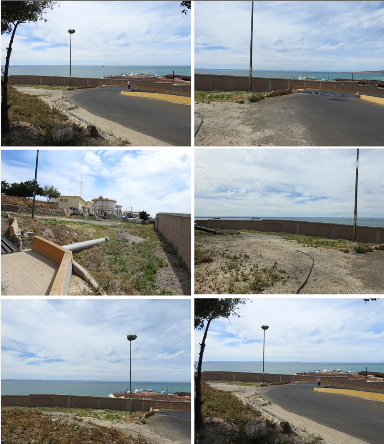
Foto VIII.6-2. Condición general del área que habrá de modificarse debido a la reconfiguración de la curva que da acceso al sitio de alojamiento de las aeroderivadas
