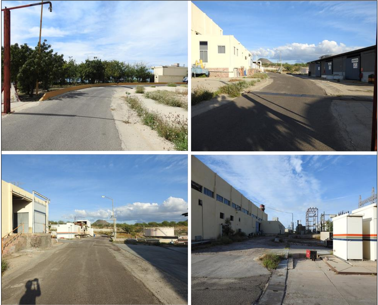
Foto VIII.6-5. Condición general de la trayectoria del cable de potencia de conectará las aeroderivadas con la Subestación Eléctrica PUI de las CT Punta Prieta
