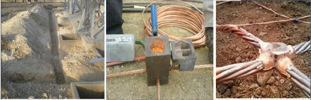
Foto II.2.4.2-3. Ejemplo colocación de un sistema de tierras (imagen de archivo)
