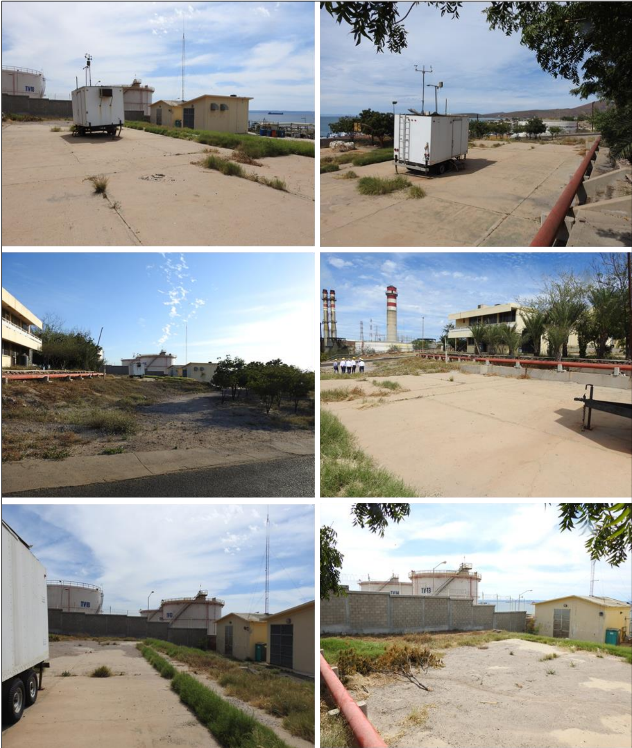
Foto VIII.6-3. Condición general del sitio donde se pretende alojar una de las aeroderivadas
