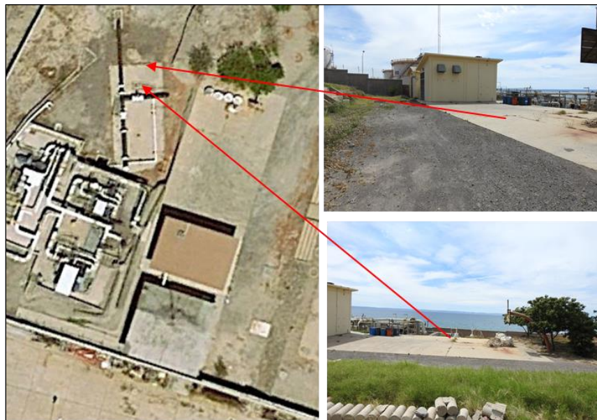
Foto II.2.4.1-3. Vista general del sitio pretendido para instalar el almacén temporal de obra
