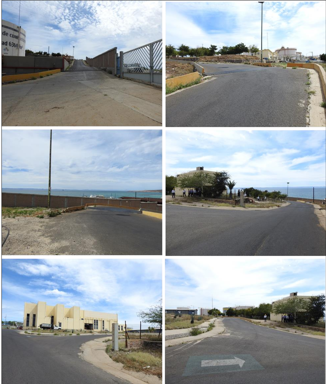
Foto VIII.6-1. Vialidades dentro de la CT Punta Prieta que se utilizarán para el traslado de las aeroderivadas hasta el sitio de su alojamiento
