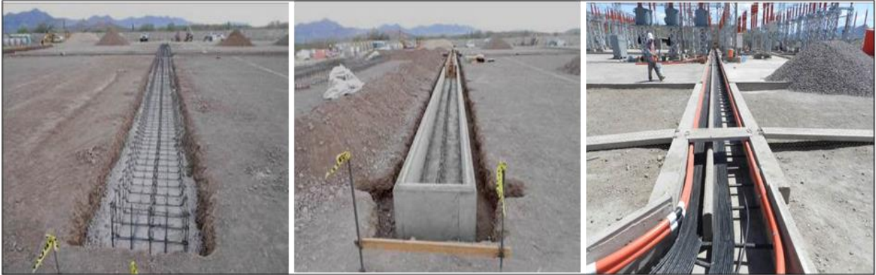
Foto II.2.4.2-1. Ejemplo de la construcción de trincheras para cableado eléctrico (imagen de archivo)
