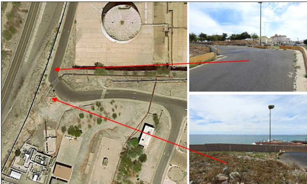
Foto II.2.4.1-1. Vista general del sitio donde se pretende acondicionar el camino de acceso (reconfiguración de la curva) para el ingreso de las aeroderivadas
