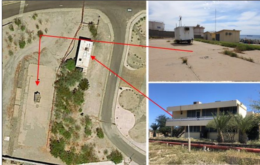
Foto II.2.4.1-2. Vista general de la infraestructura que habrá de demolerse (losa de concreto) y acondicionarse (edificio de energéticos) en el sitio que alojará las aeroderivadas
