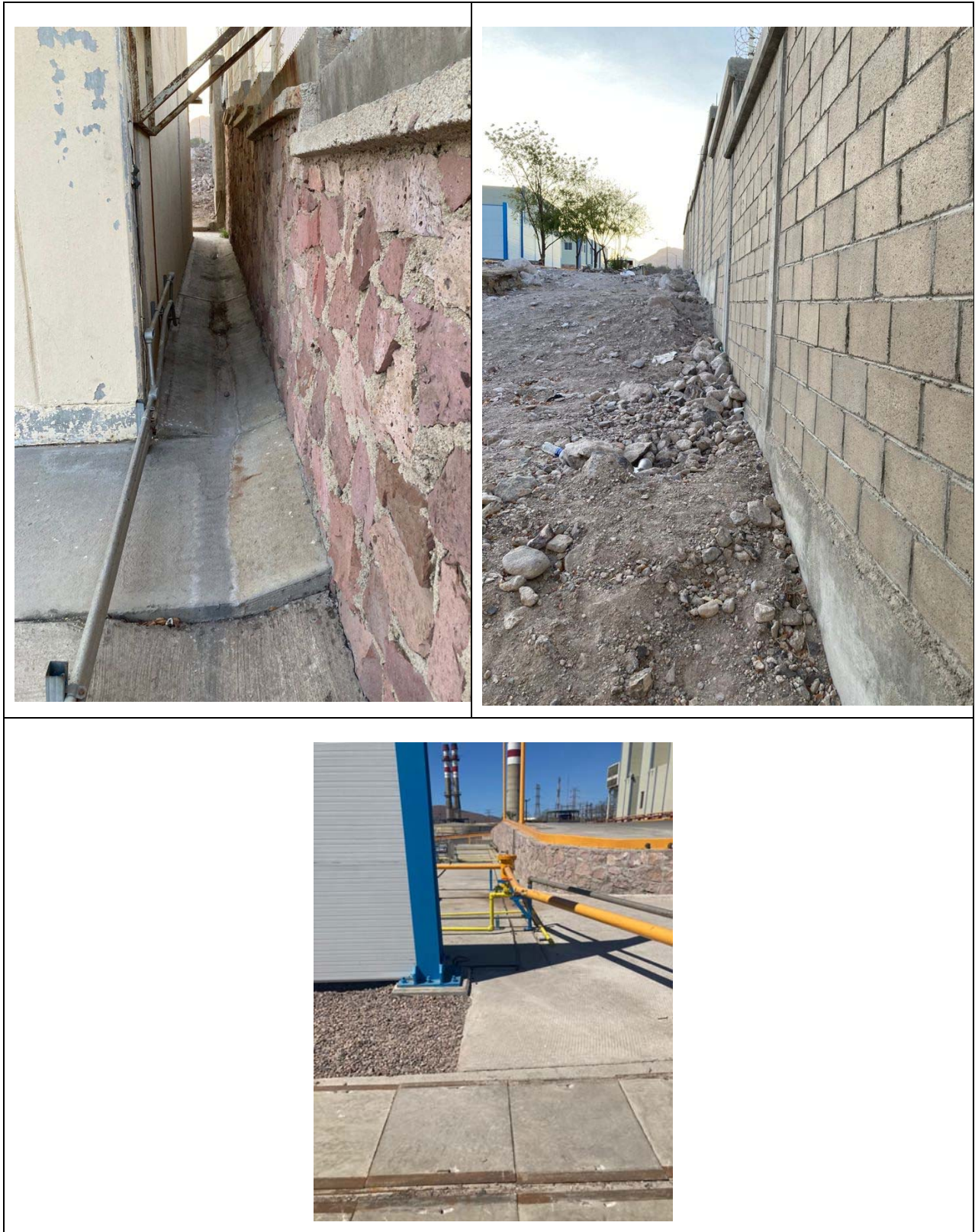
Foto VIII.7-2. Condición general del área para la instalación de la tubería y operación con Gas Natural
