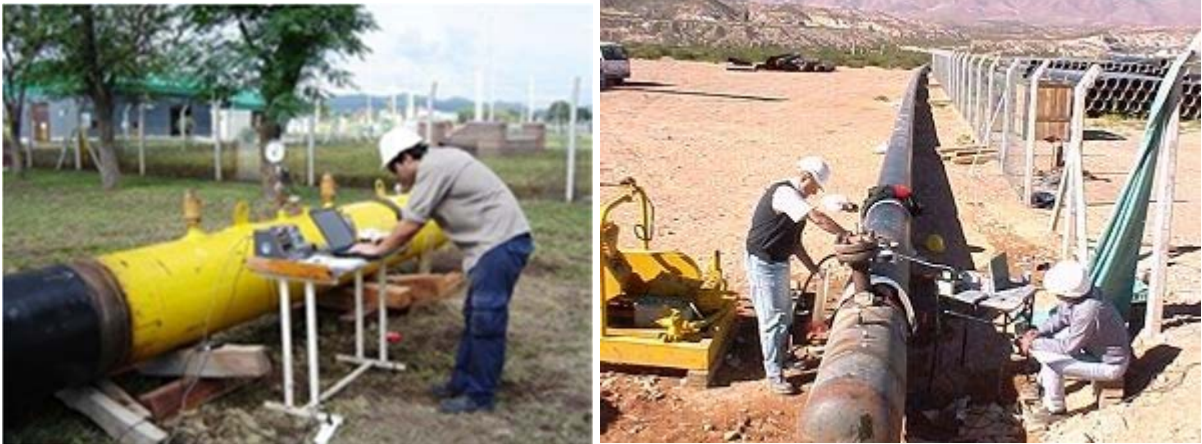
Figura II.12. Ejemplos de pruebas hidrostáticas de tubería de gas
