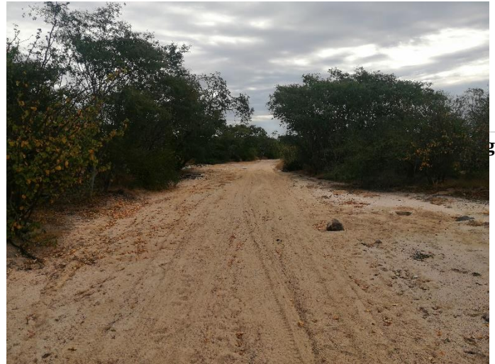
Figura 22. Cauce y Zona Federal en Km 1+550
