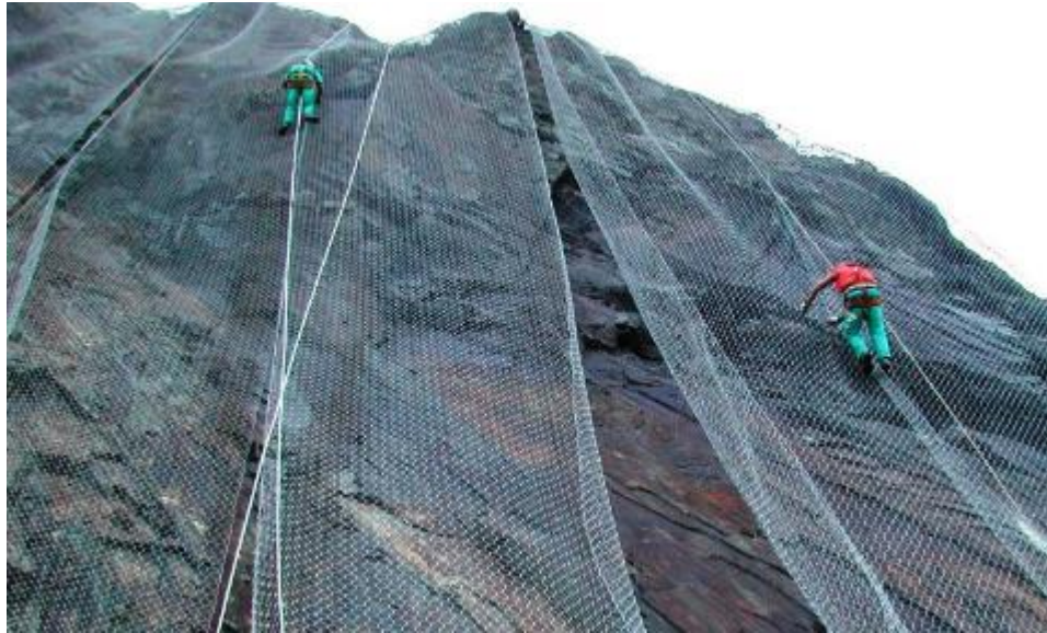
Figura 12. Tendido de malla.
