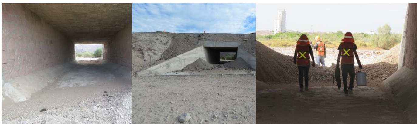
Figura 10. Imagen de obras amplias para el paso de agua y actividades de limpieza realizadas en el municipio de la Paz, BCS.
