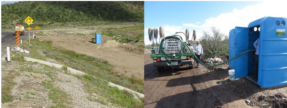
Figura 9. Imágenes de la instalación de sanitarios portátiles, su limpieza o mantenimiento a cargo de empresas debidamente autorizadas para su fin.
