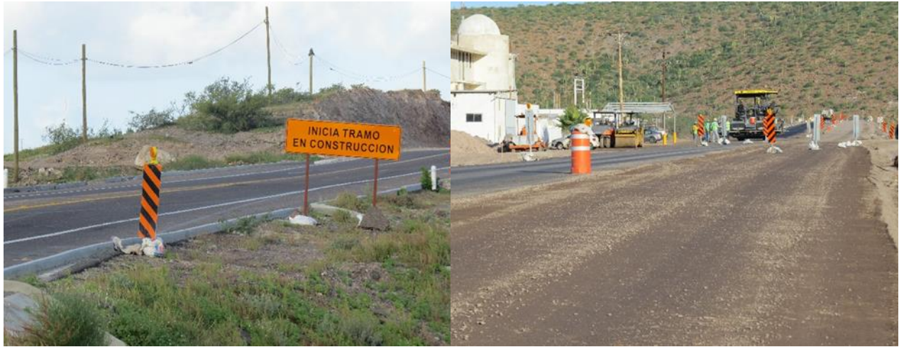
Figura 3. Señalamientos preventivos durante actividades de construcción y mantenimientos.
