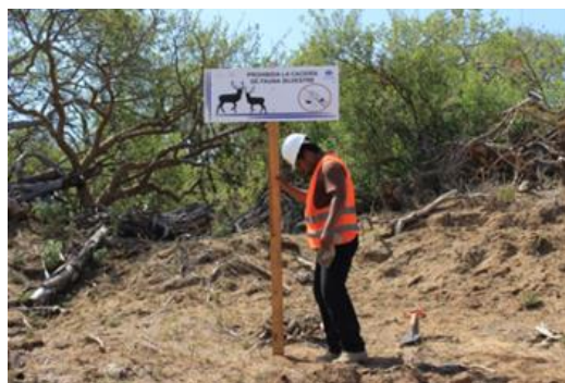
Figura 24. Ejemplificación de la colocación de un letrero temporal.
