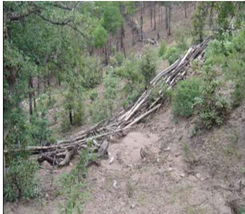
Figura IV. 112 Ejemplo de una Terraza de ramas
