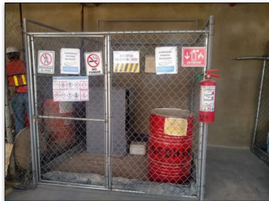
Figura VII. 4 Ejemplo de contenedor y almacén para residuos peligroso y de manejo especial
