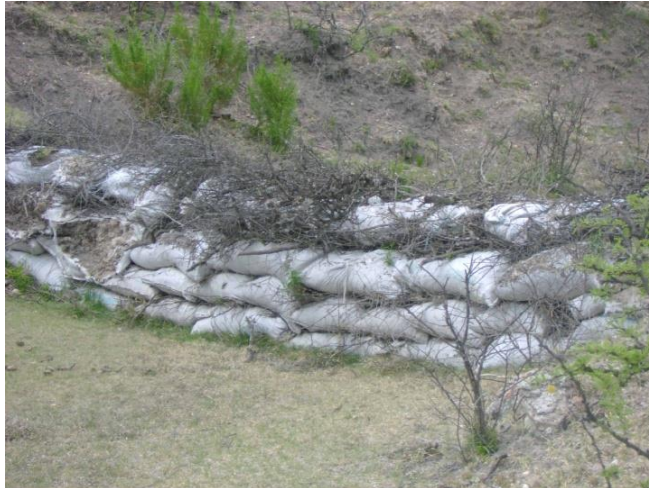
Figura VI. 25 Ejemplo de una terraza de costales
