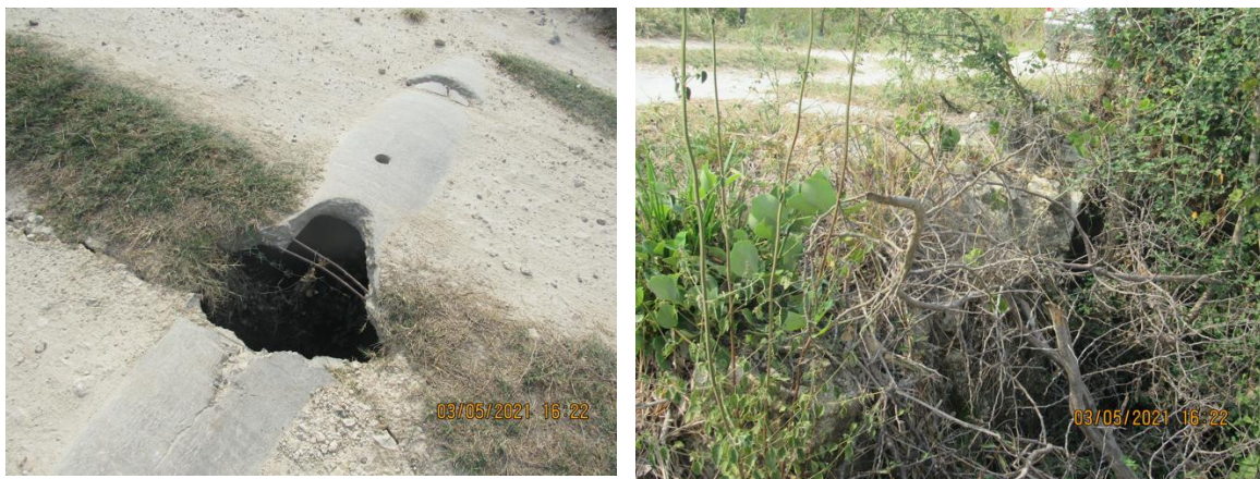
FIGURA IV-20 FOTOGRAFÍAS DE LAS OBRAS DE DRENAJE PARA LAS CORRIENTES DE AGUA DEL PROYECTO
