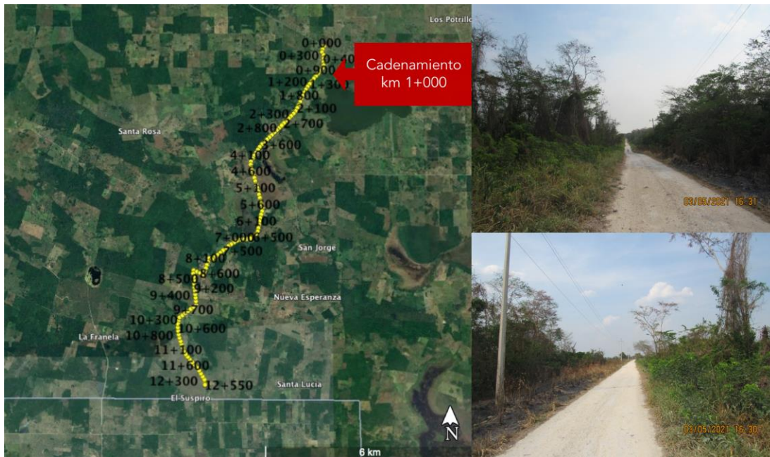
FIGURA II- 6 FOTOGRAFÍAS DEL KM 1+000 DEL CAMINO RURAL
