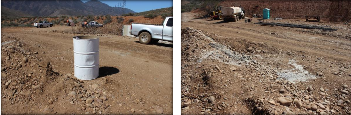
FIGURA II- 32 SE MUESTRAN FOTOGRAFÍAS DE FRENTES DE OBRAS DE CARRETERAS
