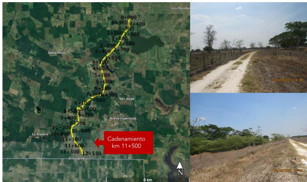
FIGURA II- 27 FOTOGRAFÍAS DEL KM 11+500 DEL CAMINO RURAL
