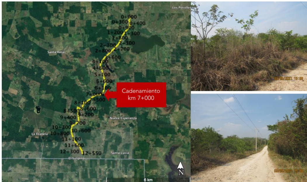
FIGURA II- 18 FOTOGRAFÍAS DEL KM 7+000 DEL CAMINO RURAL
