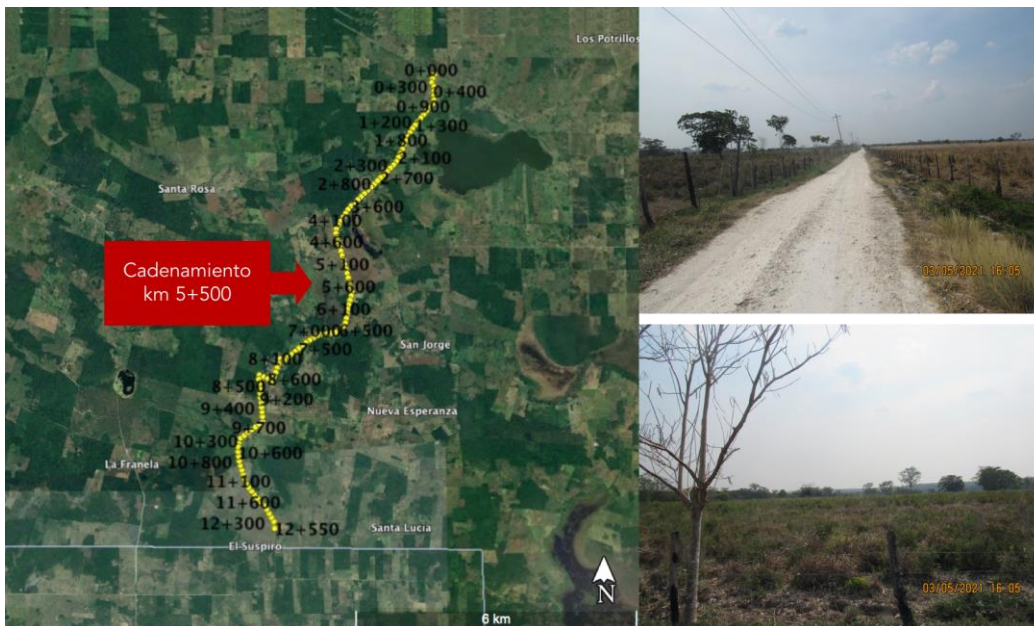
FIGURA II- 15 FOTOGRAFÍAS DEL KM 5+500 DEL CAMINO RURAL
