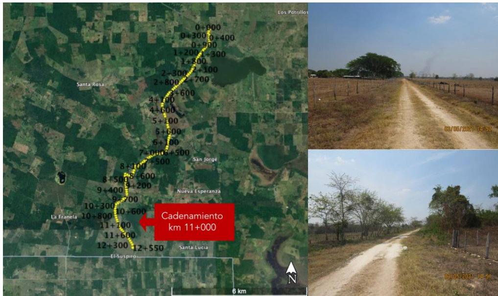
FIGURA II- 26 FOTOGRAFÍAS DEL KM 11+000 DEL CAMINO RURAL
