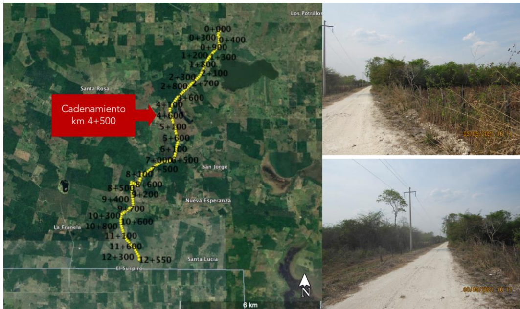
FIGURA II- 13 FOTOGRAFÍAS DEL KM 4+500 DEL CAMINO RURAL
