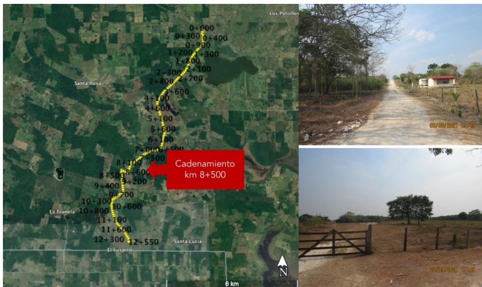
FIGURA II- 21 FOTOGRAFÍAS DEL KM 8+500 DEL CAMINO RURAL
