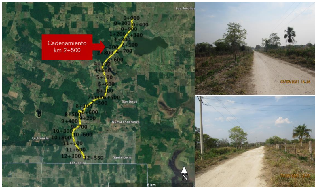
FIGURA II- 9 FOTOGRAFÍAS DEL KM 2+500 DEL CAMINO RURAL
