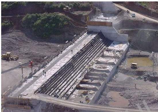
Obra de contención
