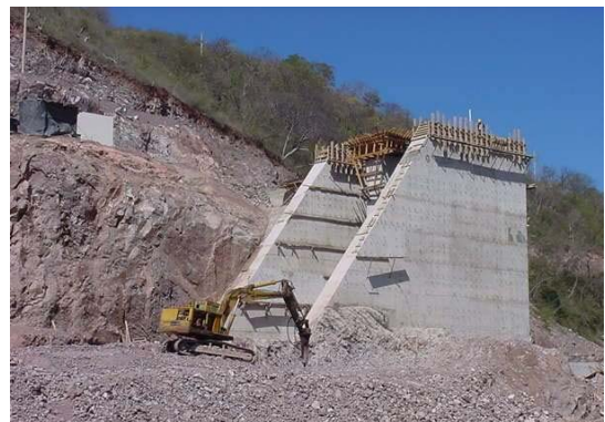
Obra de desvío
