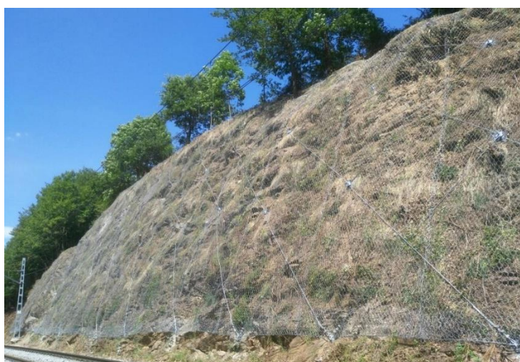
Figura VII-7. Ejemplo de estabilización de talud por malla de triple torsión.
