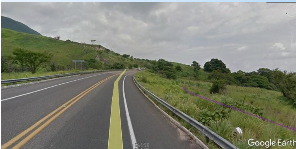
Figura IV. 10. Evidencia de perturbación en las áreas aledañas a la carretera existente.
