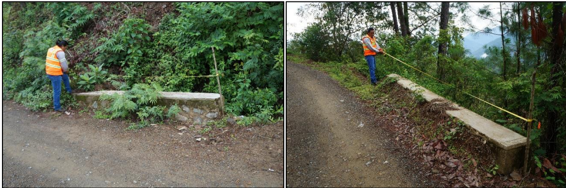
Figura IV.23 Obras de drenaje existentes que serán adecuadas al proyecto.
