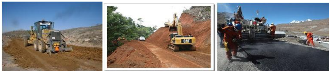
Figura II.16 Ejemplo de la construcción de un camino tipo D.
