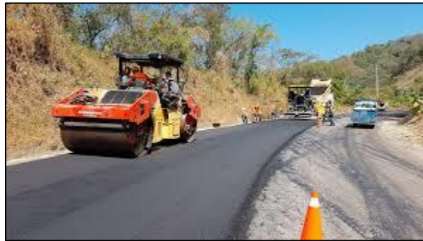
Figura V.9 Ejemplo de una carretera tipo “D” con la calzada pavimentada.
