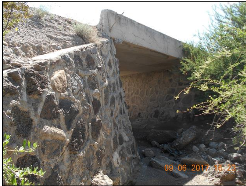
Figura VI.22 Ejemplo de una obra de drenaje adaptada como paso de fauna silvestre en una obra similar.
