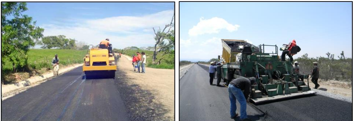
Figura II.12 Ejemplo del encarpetao asfáltico de un proyecto similar
