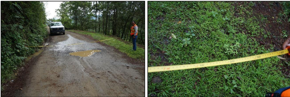
Figura II.6 Toma del ancho del camino, donde se evidencia que el camino tiene más de 7 metros de ancho, en este punto el camino tiene un ancho de 7.40 metros.
