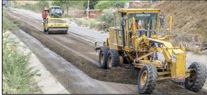
Figura V.5 Ejemplo de las actividades de construcción de un avía de comunicación similar
