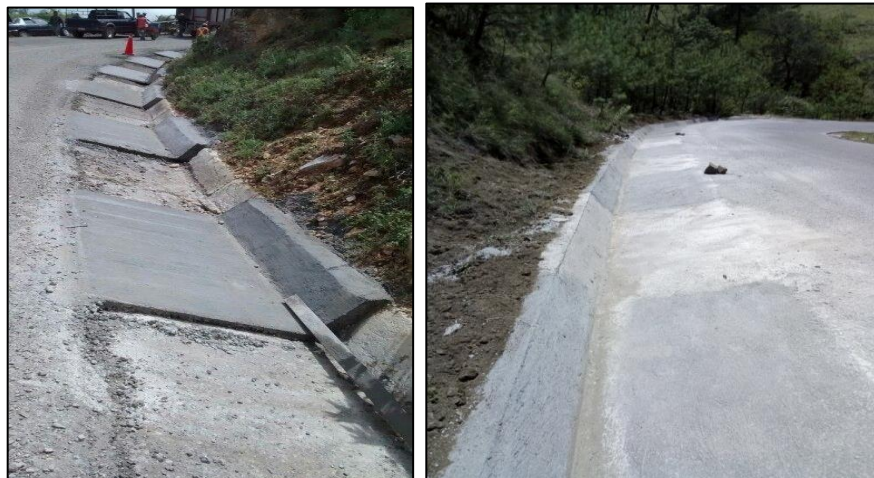
Figura V.8 Ejemplo de construcción de obras de drenaje menor (cunetas).
