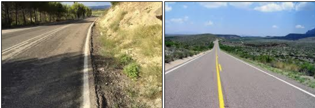
Figura VII.8 Ejemplo de carreteras tipo D en operación.
