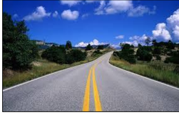
Figura VII.12 Ejemplo de una carretera tipo D en operación.
