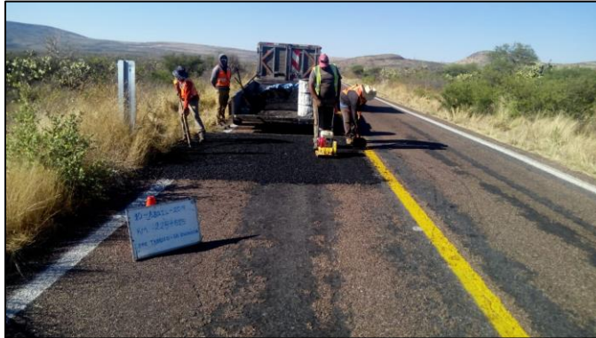
Figura II.17 Actividades de mantenimiento de una carretera similar.
