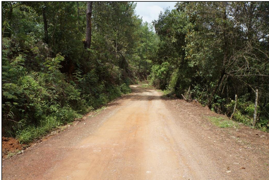
Figura I.1 Condición actual del camino Ángel Albino Corzo – Siltepec del km 12+000 al km 34+000.
