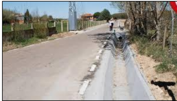
Figura V.11 Ejemplo de una obra de drenaje menor.
